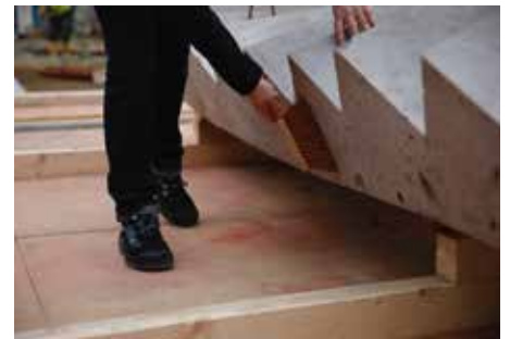
Abb. 5: Staub und Schmutz entfernen
