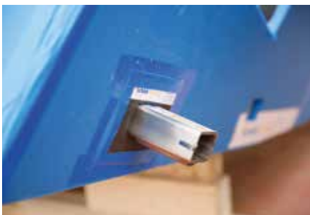
Abb. 9: Typ Q Tragelement mit Brandschutzmanschette einbauen
