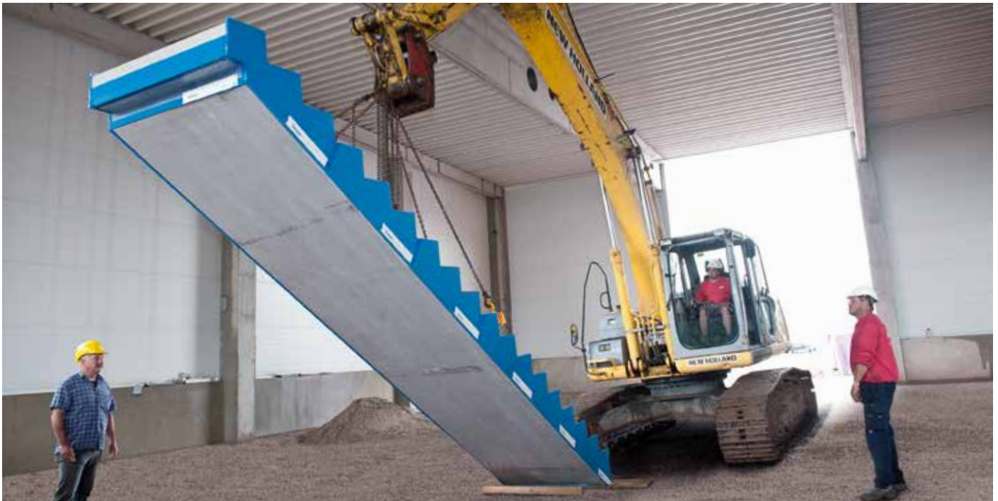
Abb. 11: Der mit Tronsole® umlaufend beklebte Fertigteilstiegenlauf kann direkt auf der Baustelle eingesetzt werden
