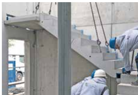
Abb. 10: Stiege einfahren und absetzen
