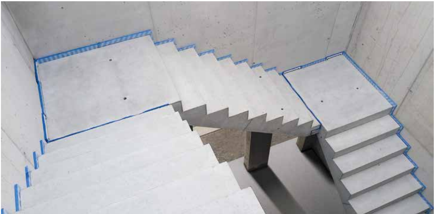
Abb. 15: Die blaue Linie zeigt den schallbrückenfreien Einbau als Qualitätsmerkmal für einen sicheren Schallschutz
