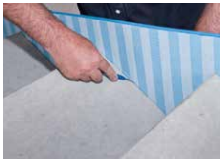
Abb. 7: Typ L Folie einritzen
