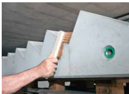
Abb. 1: Staub und Schmutz entfernen
