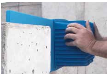
Abb. 9: Typ Z auf Baustelle wieder aufstecken
