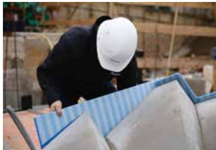
Abb. 7: Typ L Klebefolie entfernen und aufkleben
