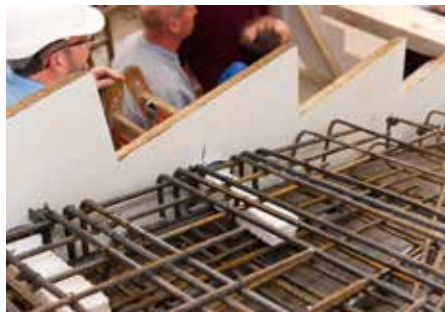
Abb. 4: Bewehrung verlegen und betonieren
