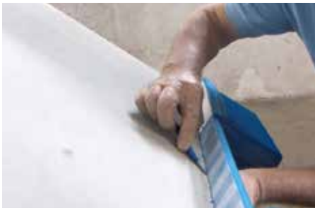
Abb. 6: Typ L Klebefolie einritzen
