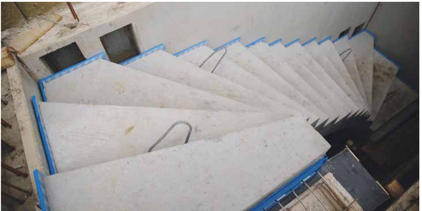
Abb. 14: Die blaue Linie zeigt den schallbrückenfreien Einbau als Qualitätsmerkmal für einen sicheren Schallschutz
