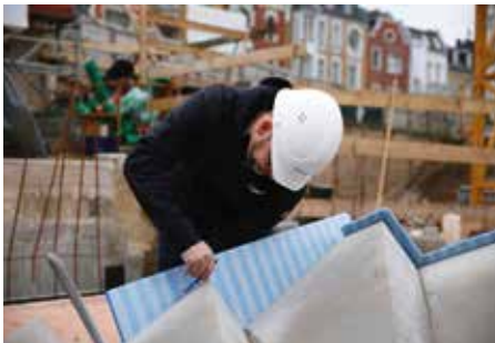
Abb. 6: Typ L Klebefolie einritzen
