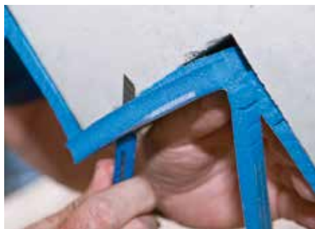
Abb. 4: Typ F Überstand abschneiden
