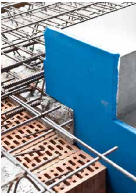
Abb. 12: Typ F oberes Auflager Elementdecke
