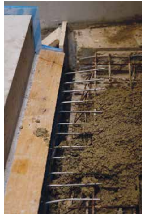
Abb. 13: Anschlussbereich Typ T betonieren
