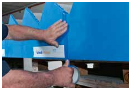
Abb. 10: Typ L Fugen mit Klebeband abdecken
