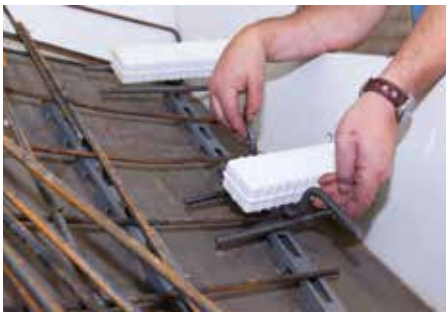
Abb. 3: Hutbügel einsetzen
