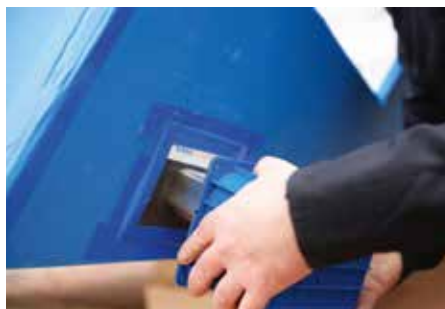
Abb. 10: Typ Q Wandelement mit Brandschutzabdeckung aufsetzen
