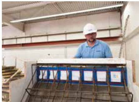
Abb. 1: Typ T einsetzen und stützen
