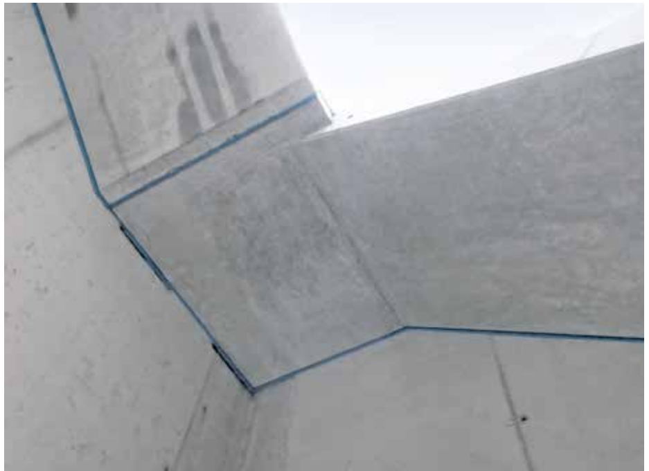
Abb. 14: Gleichmäßige blaue Linie im Fugenbereich
