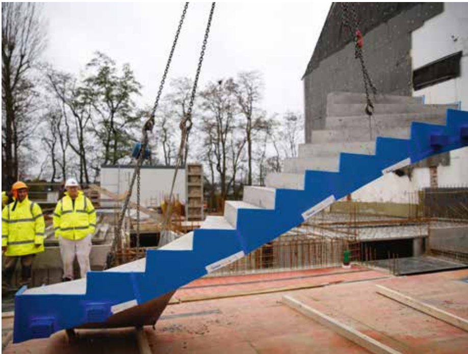
Abb. 12: Stiege anheben und einfahren
