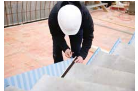
Abb. 8: Typ L mit Überstand zuschneiden
