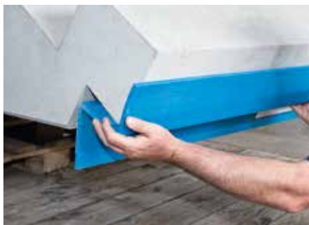
Abb. 3: Typ F ausrichten und aufkleben
