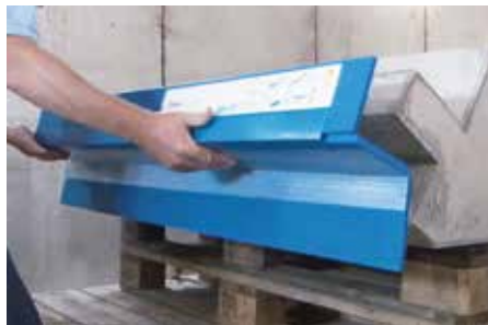
Abb. 4: Typ F ausrichten und aufkleben
