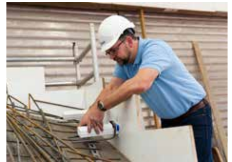
Abb. 2: Typ Q Laufhülse einbauen
