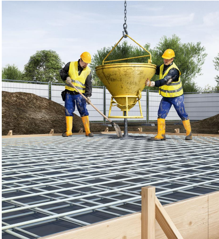
Bewehren von Beton
