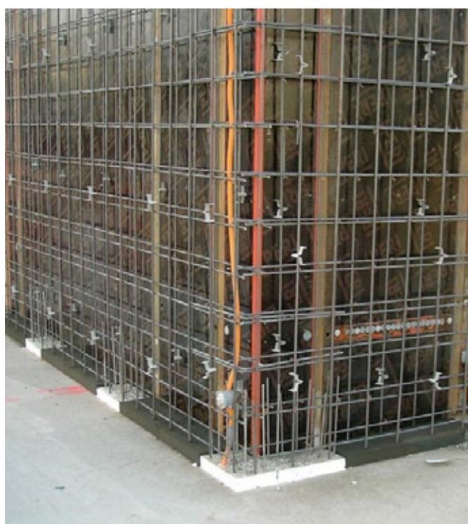
Fig. : Armature d'un mur avec des raccords isolés en pied de mur sur une dalle en béton.
