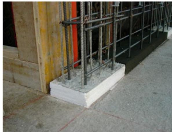
Fig. : Élément d'armature combiné avec un élément isolant (ici en verre cellulaire)
