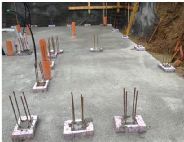
Fig. : Exemple d'éléments spéciaux (raccord isolant radier - murs)
