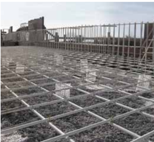
Wapening van het brugdek van de Canal Bridge, Canada
