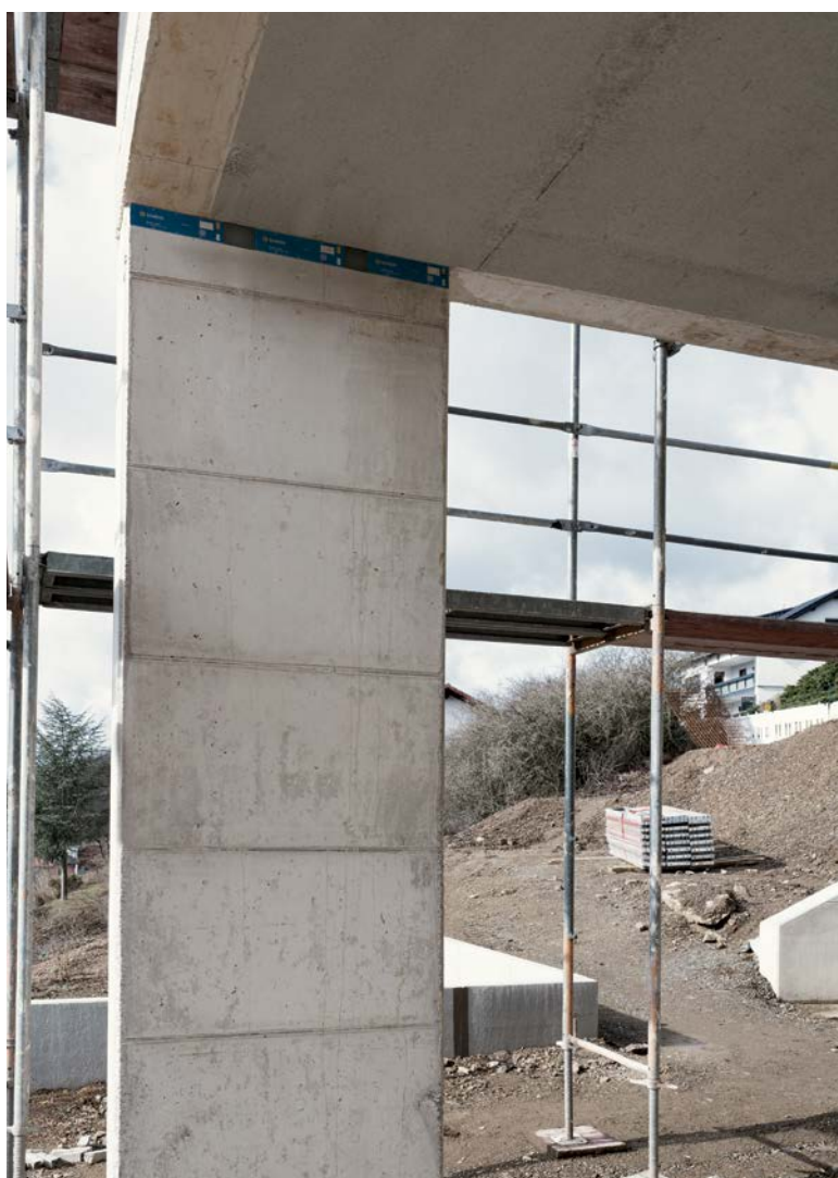
Sconnex® typu W umożliwia wykonanie wąskich słupów lub ścian o wyglądzie betonu architektonicznego z trwale wyeliminowanym mostkiem termicznym.
