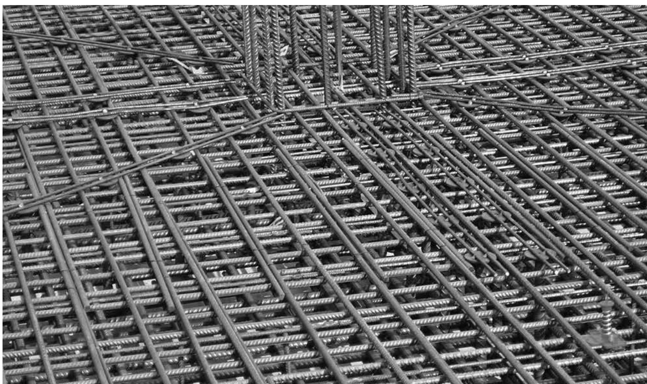
Schöck Bole® Typ O: Verlegung bei engsten Platzverhältnissen. Einbau erfolgt von oben nach der Verlegung der kompletten Bewehrung.
