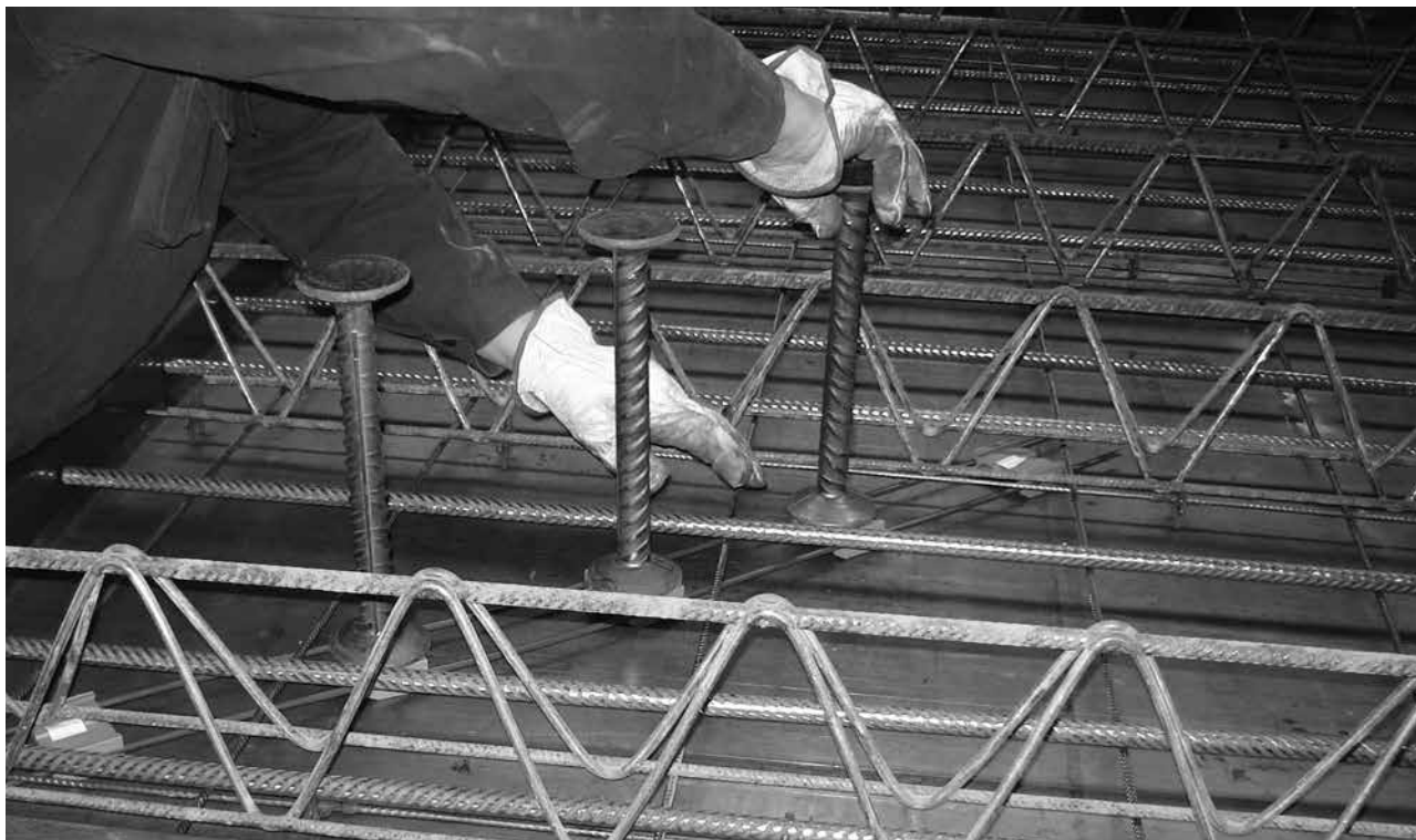
Schöck Bole® Typ F: Eindrehen der Bolzen in Kunststoffleisten nach dem Verlegen der unteren Bewehrung.
