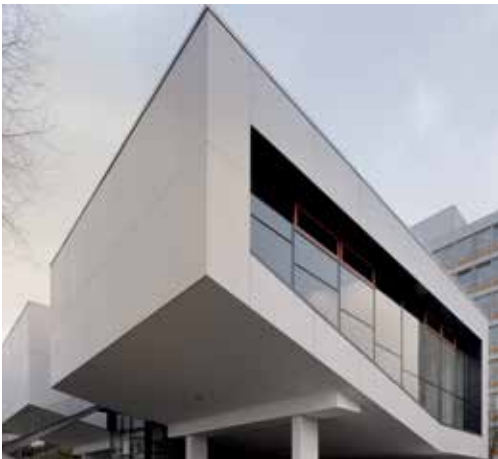
Fassadenplatten am Hörsaalgebäude der RWTH Aachen, 2010
