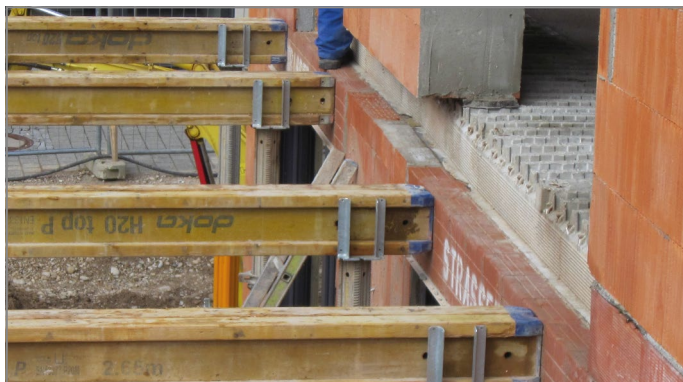
Abb. 49: Mauerwerk über ausgeschalteten Aussparungen
