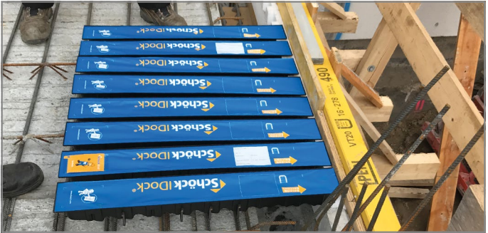
Abb. 34: Deckenelement einsetzen, Bewehrung in Vertiefung der Aussparungselemente hochziehen und verördeln
