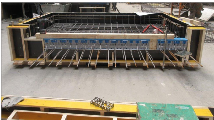
Abb. 20: Schalung, Bewehrung und Schöck Isokorb® Ausführungsvariante ID
