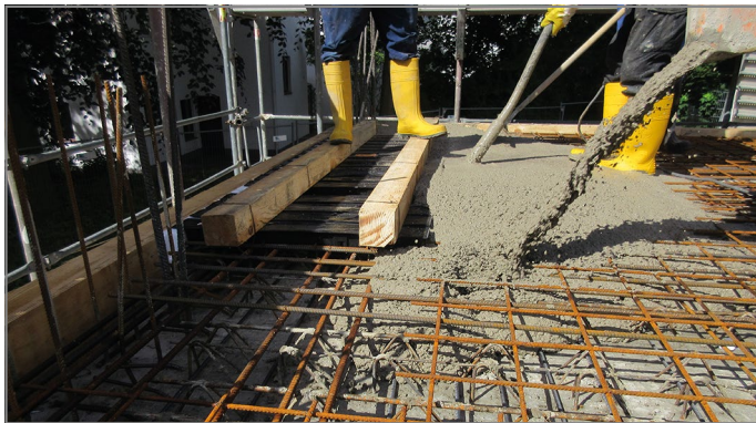
Abb. 39: Am Schöck IDock® Deckenelement betonieren
