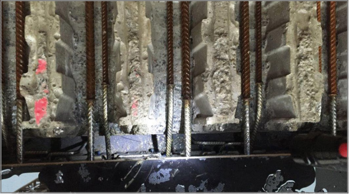
Abb. 68: Aussparungsbereich vorgenässt
