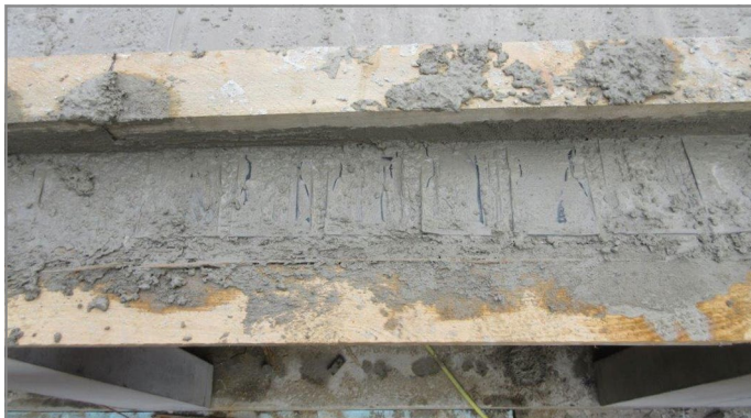
Abb. 43: Überschüssigen Beton entfernen
