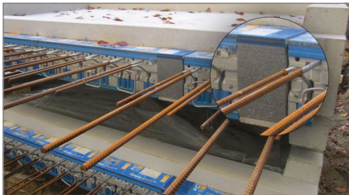
Abb. 25: Aussparung mit Abhebeanker nach Transport mit Schöck Isokorb® XT/T Typ Z verfüllt
