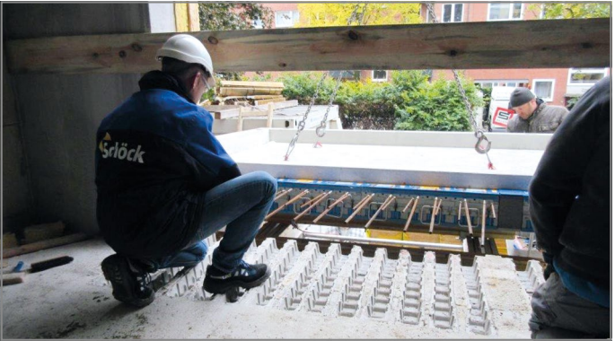
Abb. 64: Fertigteilbalkone in den Deckenaussparungen platzieren
