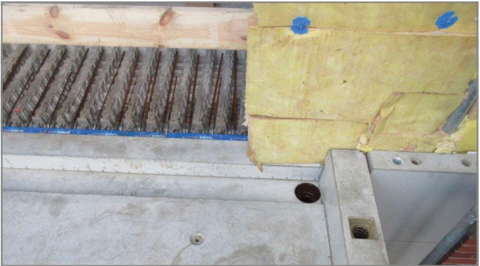
Abb. 66: Fertigteilplatten sauber in den Deckenaussparungen platziert; Balkonsicht
