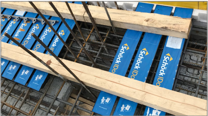
Abb. 38: Decke für das Betonieren vorbereitet
