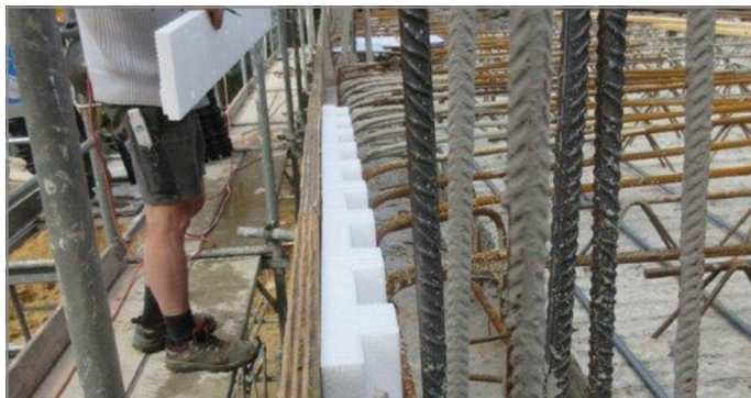
Abb. 29: Randelement auf Maß schneiden und befestigen
