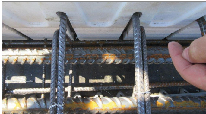
Abb. 33: Quer- und Längsbewehrung verlegen
