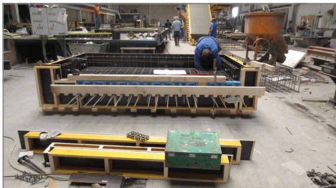
Abb. 28: Holzschablone im Einsatz
