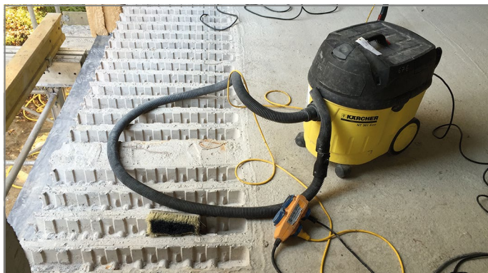
Abb. 55: Aussparung mit Industriestaubsauger reinigen
