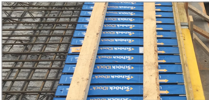
Abb. 36: Deckenelement mit Kanthölzern oder Gerüstbohlen niederhalten
