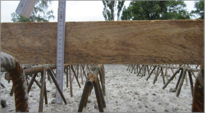
Abb. 30: Höhe der Gitterträger beachten
