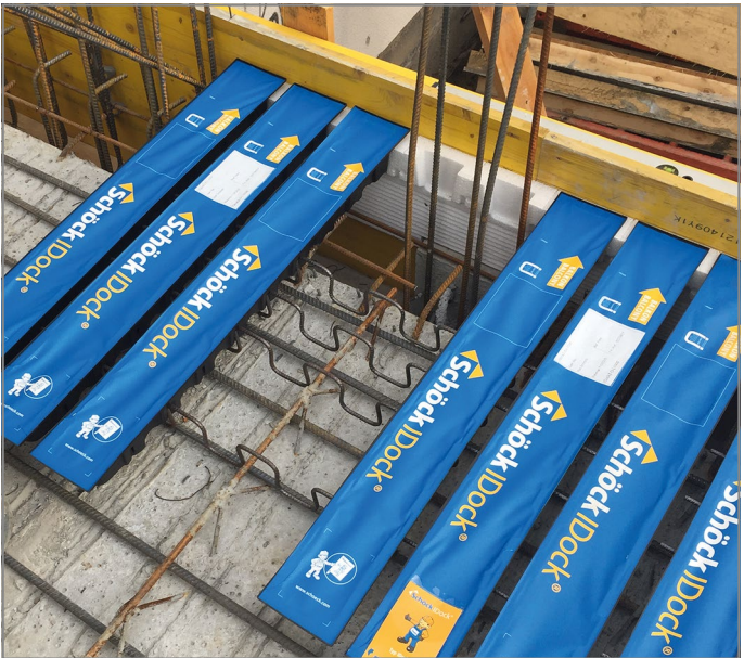
Abb. 35: Deckenelement in Position bringen und auf waagerechten Sitz prüfen
