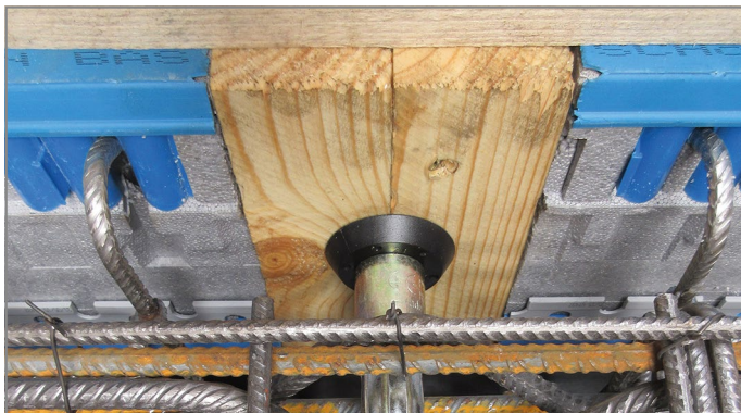
Abb. 23: Detailansicht: Aussparung für Abhebeanker
