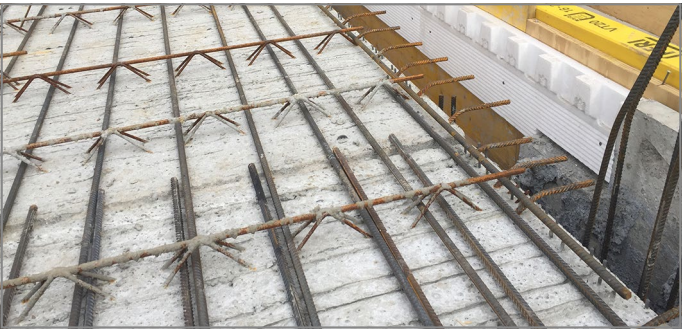
Abb. 46: Randelemente an Ortbetonschalung anheften
