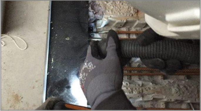
Abb. 57: Vergussbereich abdichten und überschüssiges Material entfernen
