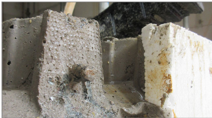
Abb. 52: Detailansicht: Decke nach Entfernen des Schöck IDock® Deckenelementes
