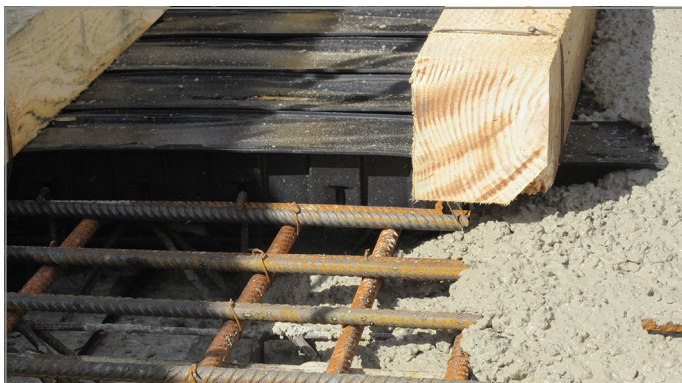
Abb. 40: Detailsicht: Am Schöck IDock® Deckenelement betonieren
