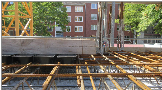
Abb. 37: Ansicht von vorne: Deckenelement mit Kanthölzern oder Gerüstbohlen niederhalten
