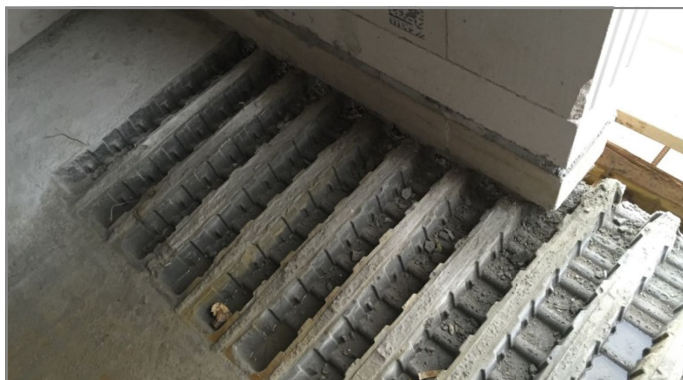
Abb. 50: Mauerwerk über ausgeschalteten Aussparungen, Detailansicht
