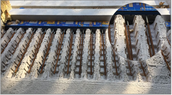
Abb. 67: Fertigteilplatten sauber in den Deckenaussparungen platziert; Deckensicht
