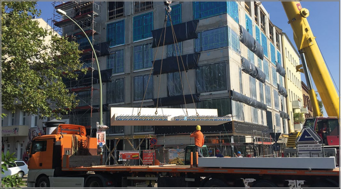
Abb. 63: Anlieferung der Fertigteilbalkone
