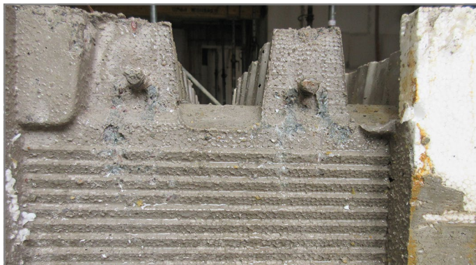
Abb. 51: Decke nach Entfernen des Schöck IDock® Deckenelementes mit sichtbarer Anschlussbewehrung
