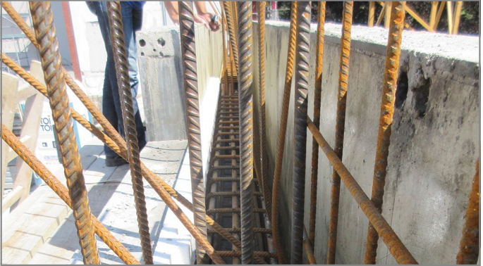
Abb. 45: Bügel vorbereiten
