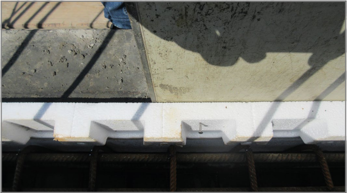
Abb. 47: Detailansicht: Randelemente an Ortbetonschalung anheften
