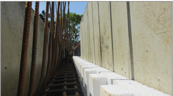
Abb. 48: Randelement an Außenwandschalung befestigt
