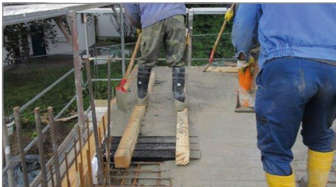
Abb. 41: Fortschreitender Ablauf des Betonierens am Deckenelement
