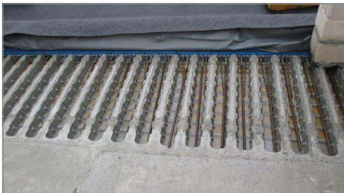
Abb. 54: Decke nach Entfernen des Schöck IDock® Deckenelementes, mit Schöck Isokorb® Ausführungsvariante ID
