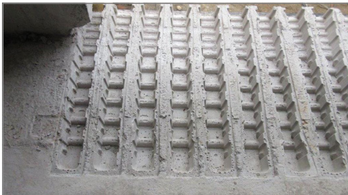
Abb. 53: Decke nach Entfernen des Schöck IDock® Deckenelementes, ohne Schöck Isokorb® Ausführungsvariante ID
