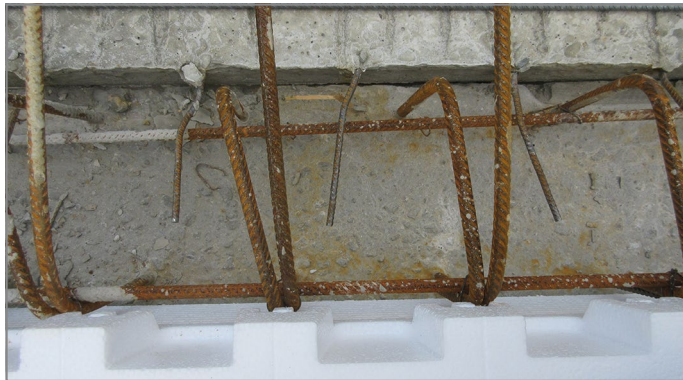
Abb. 32: Raster von Verbügelung und Randelement
