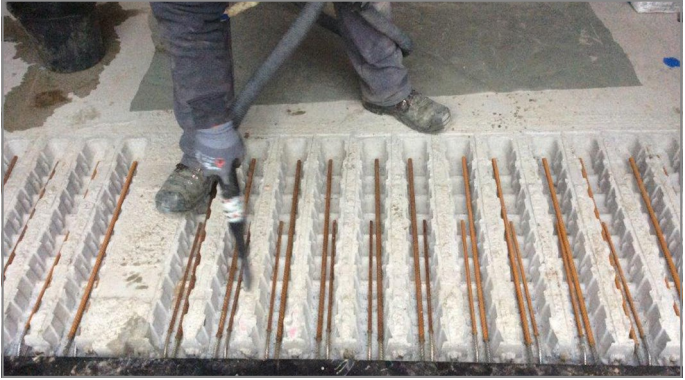
Abb. 65: Zugbewehrung des Schöck Isokorb® in die Aussparungen einführen
