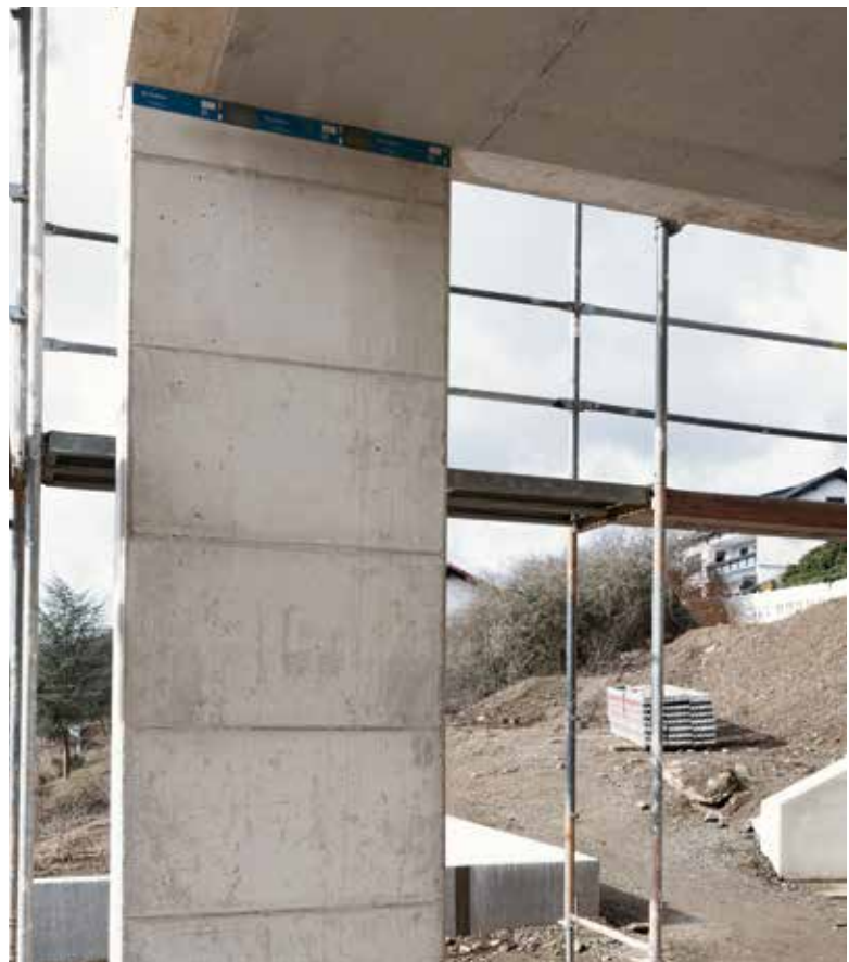
Sconnex® maakt dunne wandprofielen met een blootgestelde afwerking in beton en vermijdt voorgoed koudebruggen.
