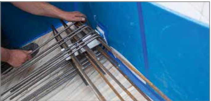
Abb. 70: Erforderliche Zusatzbewehrung verlegen
