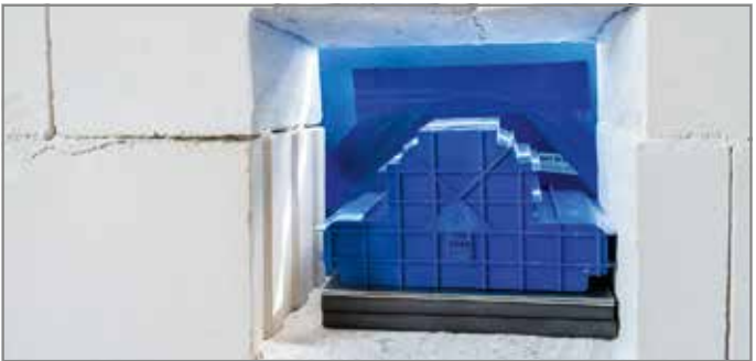
Abb. 49: Wandaussparung vergießen
