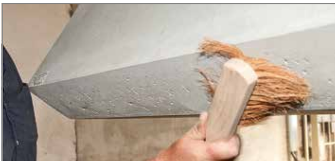
Abb. 102: Staub und lose Teile entfernen
