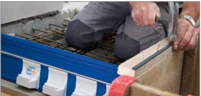
Abb. 90: Obere Nagelleiste anbringen
