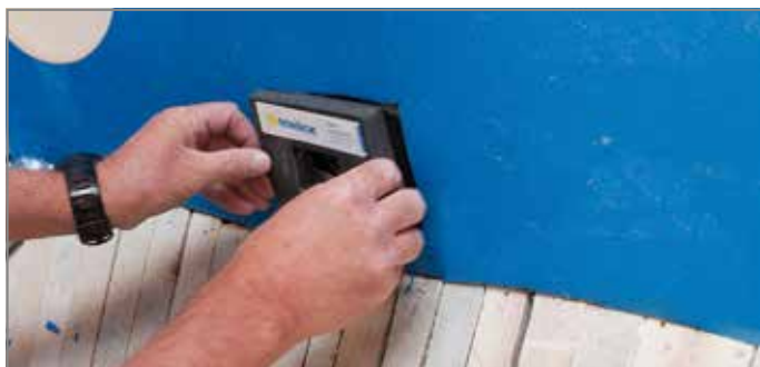
Abb. 66: Brandschutzmanschette einsetzen
