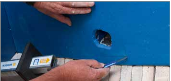
Abb. 64: Geometrie der Brandschutzmanschette ausschneiden
