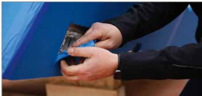
Abb. 75: Ausschnitt für die Brandschutzmanschette entfernen
