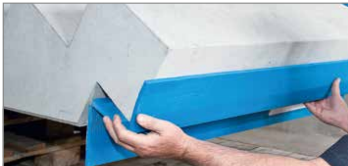
Abb. 105: Obere Schenkel von Tronsole® Typ F ankleben
