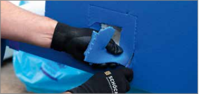
Abb. 36: Geometrie der Podesthülse ausschneiden
