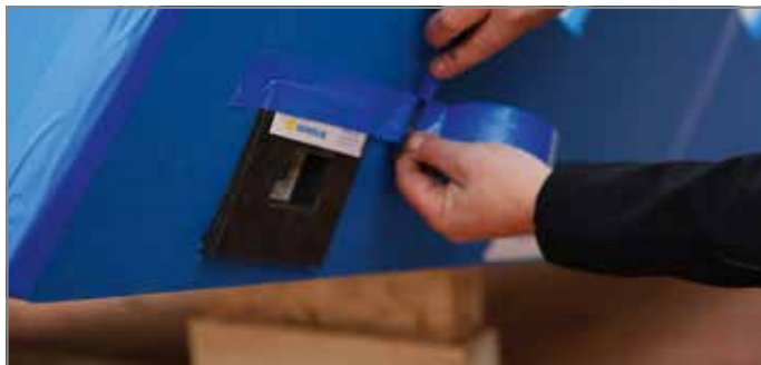
Abb. 76: Brandschutzmanschette einsetzen und abkleben
