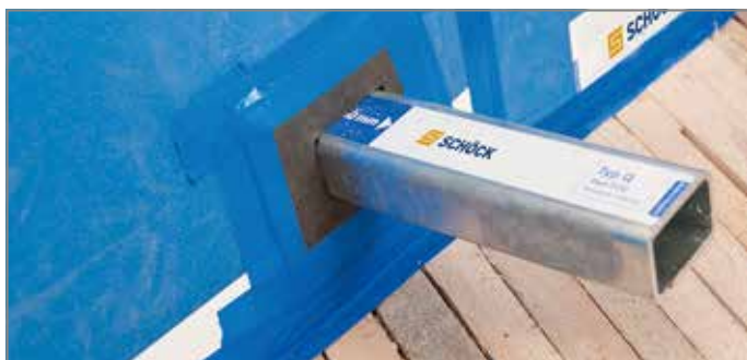
Abb. 67: Tragelement montieren und Brandschutzmanschette abkleben
