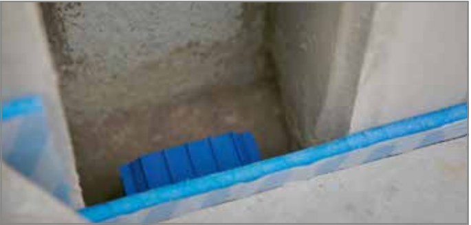
Abb. 85: Aussparung vergießen
