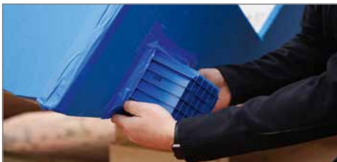
Abb. 80: Wandelement für Einbauzustand waagerecht ausrichten und abkleben
