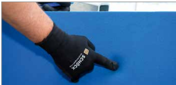
Abb. 33: Aussparung der Podesthülse ertasten
