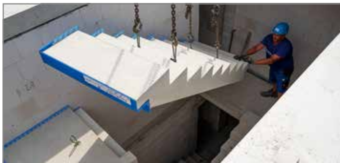
Abb. 47: Treppenlauf einheben
