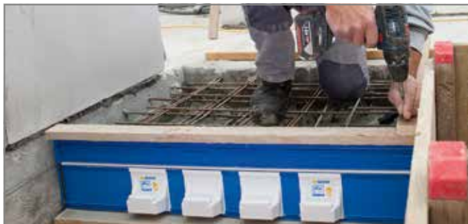
Abb. 92: Tronsole® Typ T abstützen
