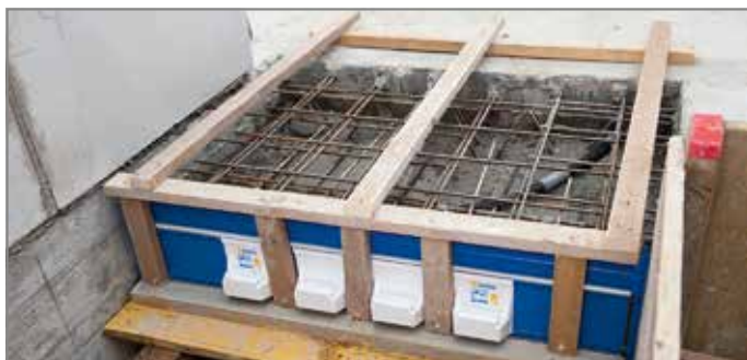
Abb. 93: Vor dem Betonieren
