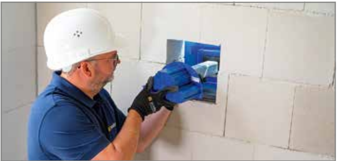
Abb. 43: Tragelement und Wandelement in Podesthülle einfahren
