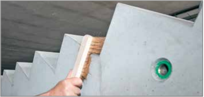
Abb. 135: Staub und lose Teile entfernen
