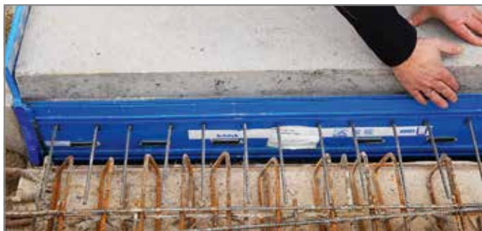
Abb. 96: Treppe einsetzen und stützen
