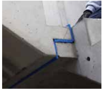
Abb. 3: Blaue Linie zeigt durchgängige Entkopplung
