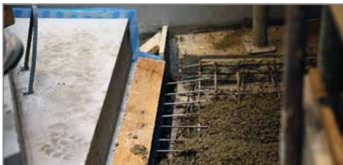
Abb. 97: Anschlussbereich betonieren
