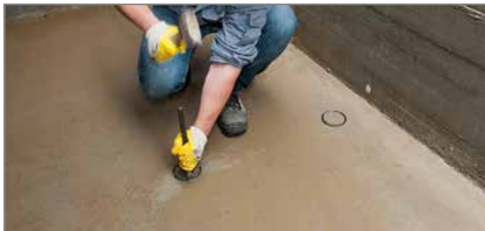
Abb. 115: Kernbohrung ausbrechen
