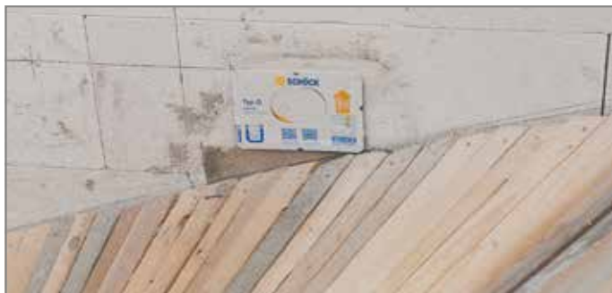
Abb. 59: Wandelement Tronsole® Typ Q in KS-Wand eingemauert
