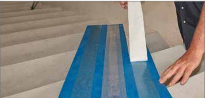
Abb. 109: Schutzfolie von Tronsole® Typ B abziehen
