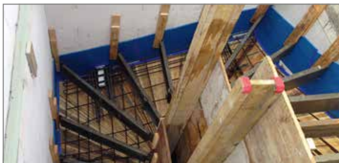
Abb. 130: Treppenlauf bewehren und Stufenbretter anbringen
