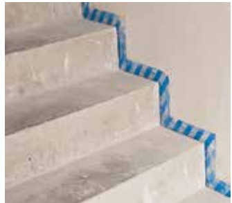
Abb. 5: Blaue Linie zeigt durchgängige Entkopplung
