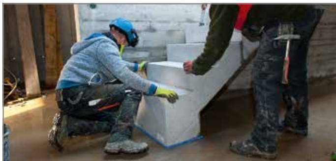
Abb. 121: Treppe absetzen
