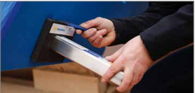
Abb. 74: Geometrie der Brandschutzmanschette ausschneiden
