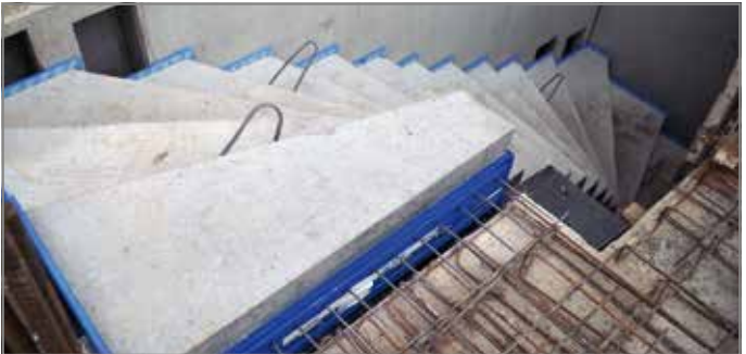
Abb. 100: Druckfuge ( \geq 40 \text{ mm} ) zwischen Tronsole® Typ T und Decke/Podest prüfen
