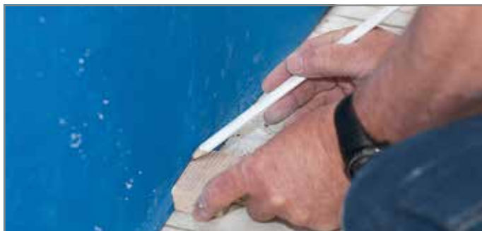
Abb. 125: Unteres Laufprofil von Tronsole® Typ L anzeichnen
