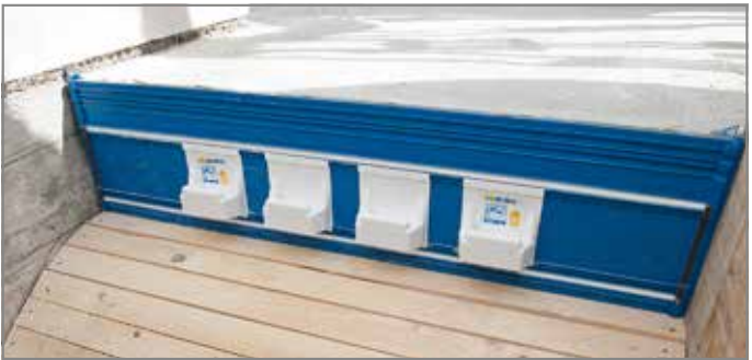
Abb. 95: Oberer Anschluss mit Tronsole® Typ T
