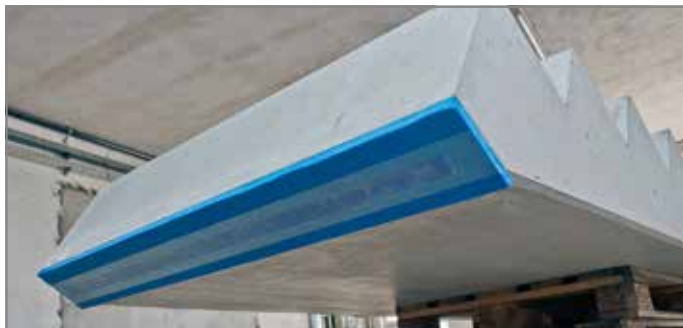
Abb. 112: Tronsole® Typ B aufgeklebt
