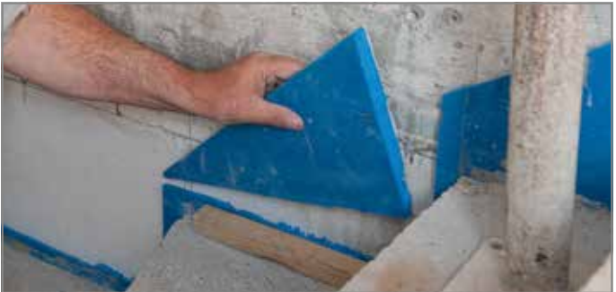
Abb. 132: Tronsole® Typ L mit Überstand abschneiden
