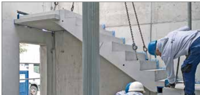
Abb. 54: Treppenlauf positionieren
