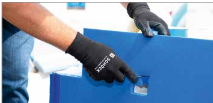
Abb. 34: Geometrie der Podesthülse ausschneiden
