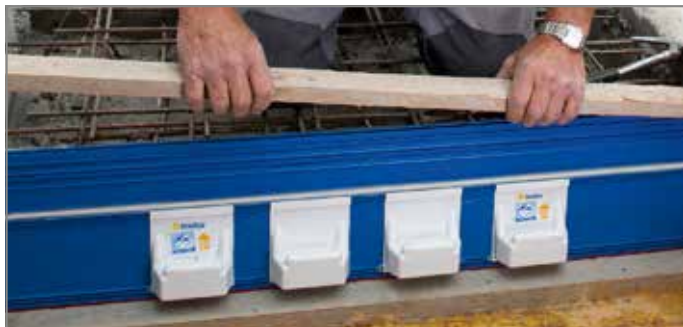
Abb. 91: Obere Nagelleiste in Tronsole® Typ T einklipsen
