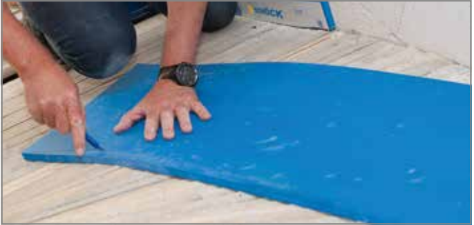
Abb. 126: Unteres Laufprofil von Tronsole® Typ L zuschneiden
