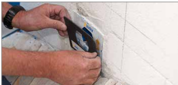
Abb. 61: Brandschutzabdeckung aufkleben
