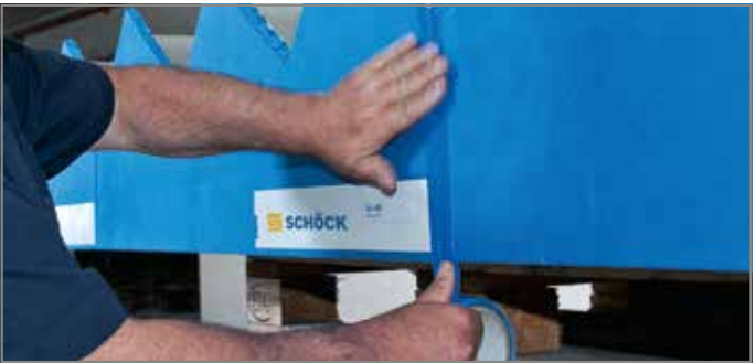
Abb. 142: Stöße von Tronsole® Typ L verkleben
