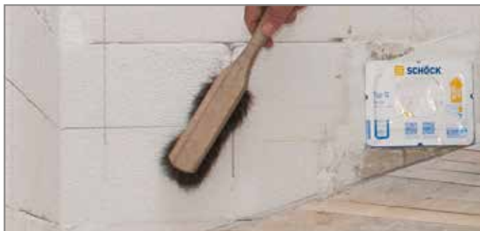
Abb. 123: Staub und lose Teile entfernen
