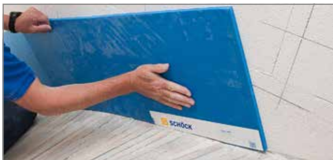
Abb. 129: Tronsole® Typ L aufkleben
