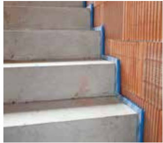
Abb. 9: Schöck Tronsole® trennt die Bauteile vollflächig und minimiert die Gefahr von Schallbrücken.
