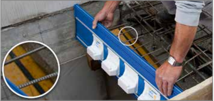
Abb. 88: Tronsole® Typ T einsetzen
