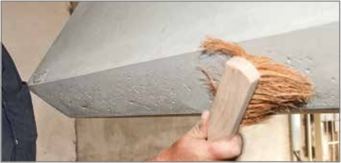
Abb. 108: Staub und lose Teile entfernen
