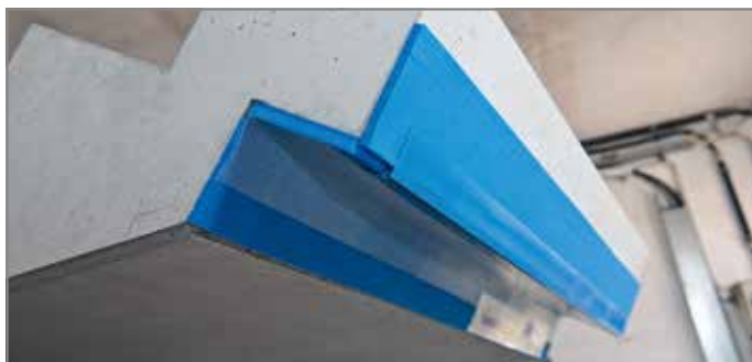
Abb. 107: Tronsole® Typ F fertig montiert.
