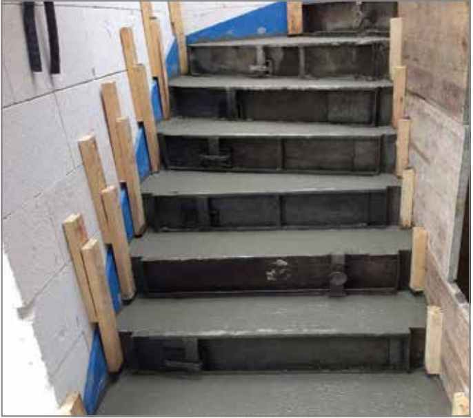
Abb. 131: Treppenlauf betonieren
