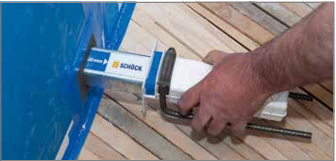
Abb. 69: Laufhülse aufstecken
