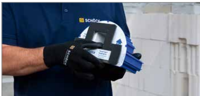
Abb. 41: Brandschutzabdeckung am Wandelement aufkleben
