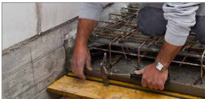
Abb. 87: Untere Nagelleiste anbringen, Abstand von \geq 40 \text{ mm} zu Tronsole® Typ T einhalten
