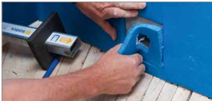
Abb. 65: Ausschnitt für die Brandschutzmanschette entfernen
