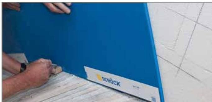
Abb. 124: Unteres Laufprofil von Tronsole® Typ L anzeichnen
