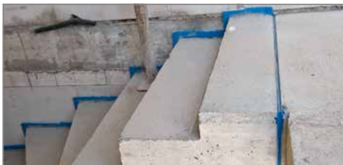
Abb. 134: Gerade Fugenausbildung am Treppenaustritt
