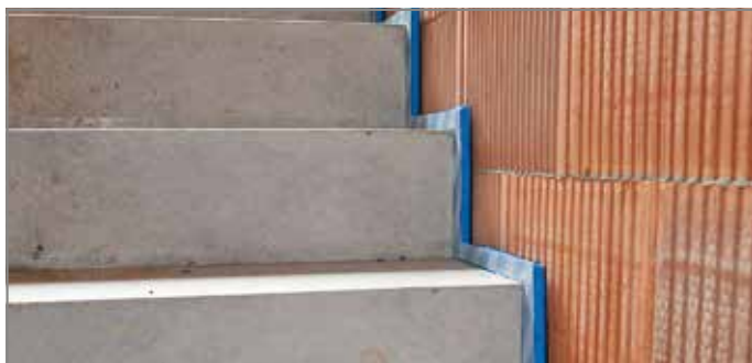
Abb. 145: Überstand der Fugenplatte kontrollieren
