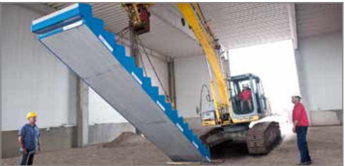
Abb. 143: Vorbereitete Treppe einsetzen
