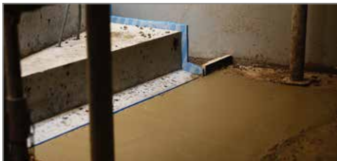
Abb. 98: Anschlussbereich betoniert
