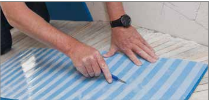
Abb. 127: Schutzfolie etwa 150 mm von der Unterkante entfernt einritzen und abziehen
