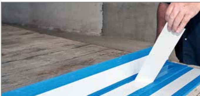
Abb. 104: Schutzfolie von Tronsole® Typ F abziehen
