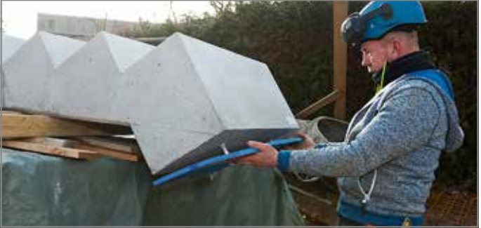
Abb. 117: Am Treppenlauf Staub und lose Teile entfernen und Tronsole® Typ B montieren
