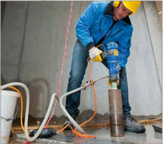
Abb. 114: Kernbohrung mit 100 mm Durchmesser in Bodenplatte setzen
