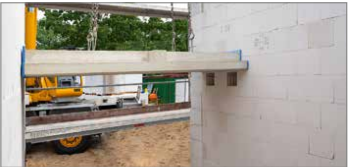
Abb. 38: Podest zwischen den Treppenhauswänden einheben
