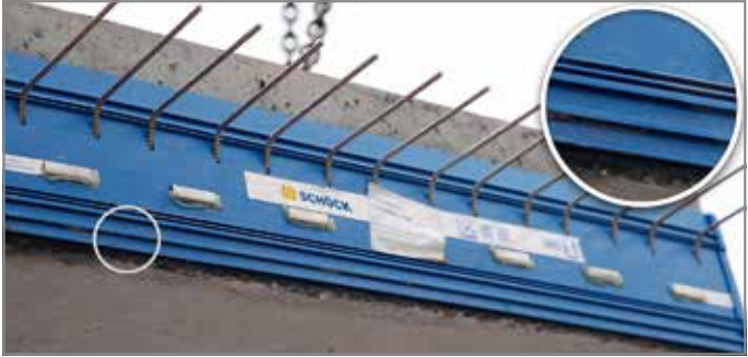
Abb. 101: Nagelleiste unbedingt entfernen
