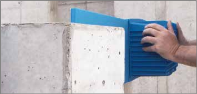
Abb. 51: Tronsole® Typ Z aufstecken
