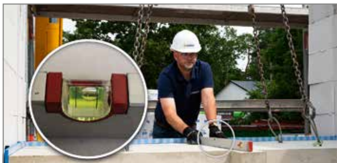
Abb. 46: Einfederung gemäß Technischer Information berücksichtigen
