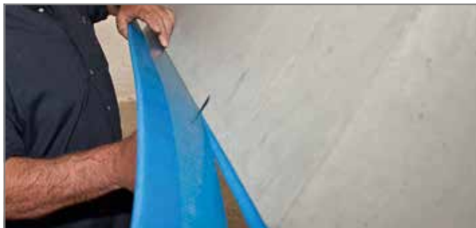
Abb. 111: Überstand von Tronsole® Typ B bündig abschneiden
