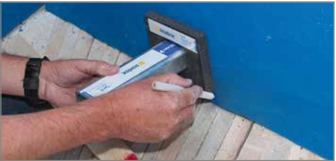
Abb. 63: Brandschutzmanschette auf Fugenplatte Typ L anzeichnen
