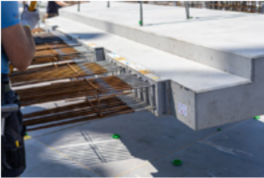
Der Einbau des Isokorb in die Balkonplatten erfolgte bereits im Fertigteilwerk. Foto: Markus Schieder
