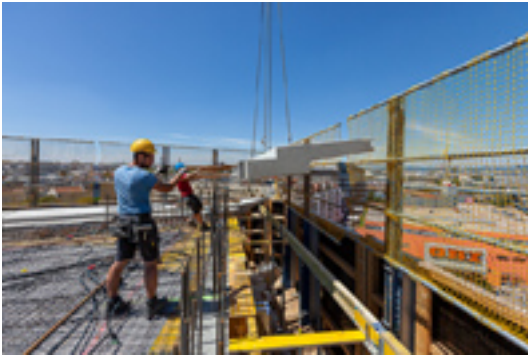
Teilweise mussten Balkenelemente konstruktiv miteinander verbunden werden. Dies geschah mit Hilfe des Schöck Querkraftdorn Stacon Typ LD. Foto: Markus Schieder
