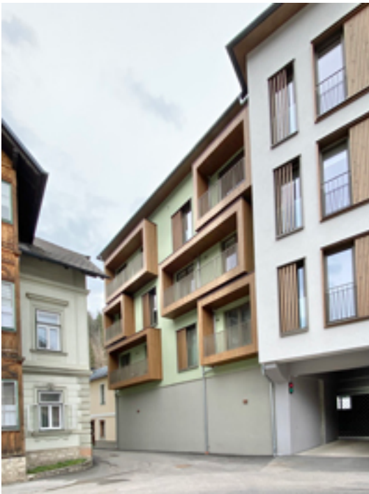
Französische Balkongeländern beleben die Fassade und dienen als Absturzsicherung für bodentiefe Fenster. Foto: ROSA Architektur Bad Mitterndorf
