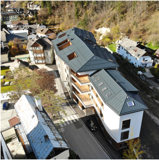
Unterschiedlich lange Balkone, abwechslungsreich über die Fassade verteilt, verleihen dem großvolumigen Gebäude eine markante Struktur. Foto: ROSA Architektur Bad Mitterndorf
