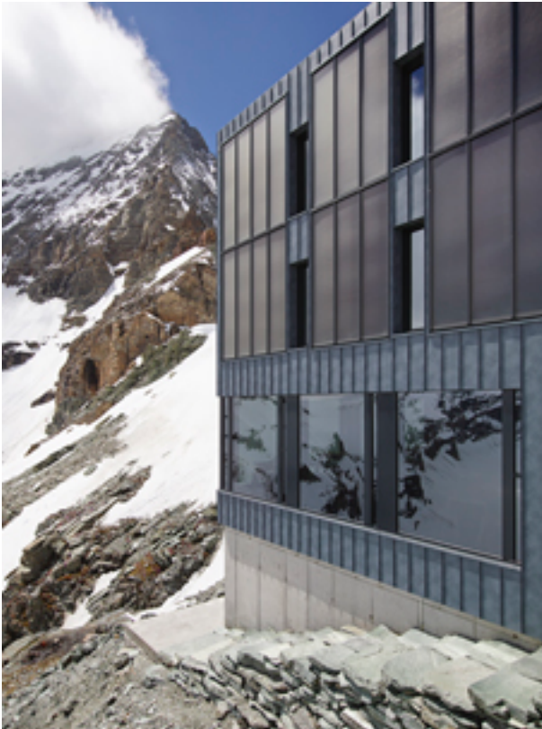
Die Wandanschlüsse im Übergang von warmen zu kalten Gebäudeteilen wurden mit Schöck Sconnex ausgeführt. Foto: Photographie Michel Bonvin.
