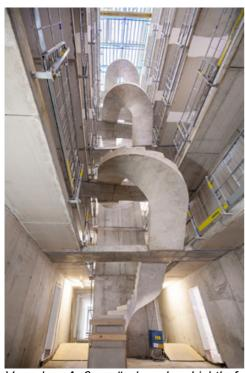
Von den Außenwänden des Lichthofs spannen dabei Stege, die von den Galerien erreichbar sind. Über jeweils einen Steg wird die zentral hängende, halbgewendelte Stahlbetontreppe in den Geschossen bedient. Foto: Schöck Bauteile GmbH
