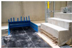
Die Tronsole wird vor der Montage der Treppen direkt auf der Baustelle eingebaut. Foto: Schöck Bauteile GmbH
