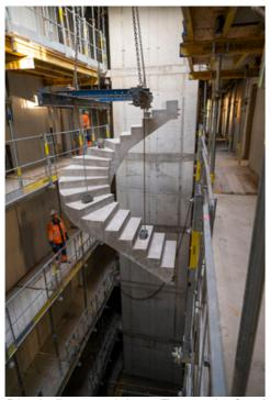
Die halbgewendelten Treppenläufe des Projekts "immergrün" wurden als Fertigteile hergestellt. Foto: Schöck Bauteile GmbH
