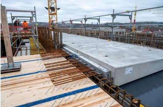
*Die sichere Befestigung und zuverlässige Lastabtragung der auskragenden Stahlbetonfertigteile an die Holzkonstruktion konnte mit Schöck Isokorb sichergestellt werden.*
