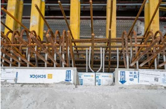
*Das Baufeld liegt in einem Erdbebengebiet (Zone 1), daher rechnen die Planer in Abstimmung mit dem Prüfingenieur und dem Bauherrn das Gebäude nach dem neuen Nationalen Anhang der Erdbebennorm DIN EN 1998-1/NA:2021-07. Zum Einsatz kam Isokorb XT Typ H, da das Wärmedämmelement ist zur Aufnahme von Erdbebeneinwirkung geeignet.*
