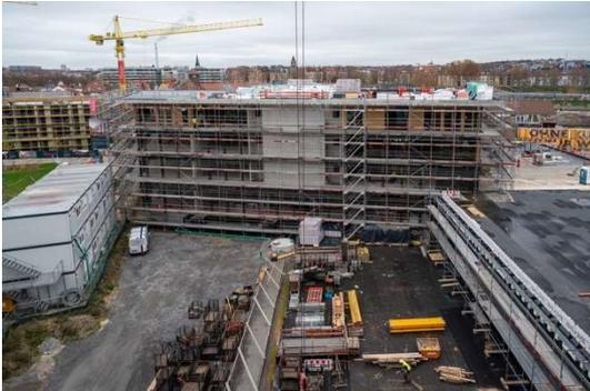
*Das Projekt „Bildungshaus NeckarPark ist das erste öffentliche Gebäude der Gebäudeklasse 5 in Holzbetonverbundbauweise in Stuttgart. Die sichere Befestigung und zuverlässige Lastabtragung der auskragenden Stahlbetonfertigteile an die Holzkonstruktion konnte mit Schöck Isokorb sichergestellt werden.*
