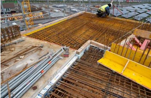
*In den Eckbereichen wurden die Balkone überwiegend in Ortbeton ausgeführt und mit verschiedenen Typen Schöck Isokorb XT Q angeschlossen.*
