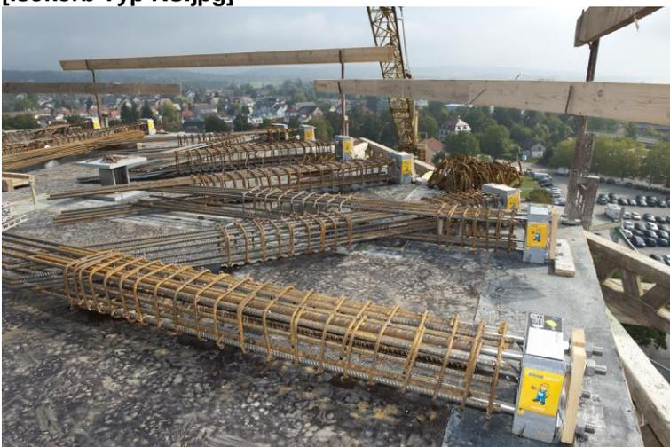
Der Schöck Isokorb Typ KS wurde eingesetzt, um Stahlbeton und Stahl zu verbinden und gleichzeitig Wärmebrücken zu reduzieren. Einsatz findet er u.a. bei der gläsernen Brüstung der Aussichtsterrassen. Foto: Schöck Bauteile GmbH, Abdruck honorarfrei.
