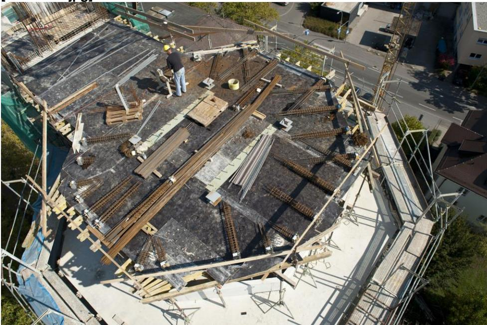
*Der ehemals 34 Meter hohe Turm wurde auf eine Schaftlänge von 20 Metern abgetragen, um fünf weit auskragende Geschosse in Stahlbeton-Bauweise aufzustocken. Foto: Schöck Bauteile GmbH, Abdruck honorarfrei.*
