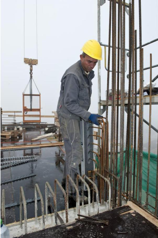
Die Decken der Stege wurden mit dem Schöck Isokorb Typ D und die durchgehenden Wände in den beiden Obergeschossen mit dem Typ W thermisch entkoppelt mit dem Hauptturm verbunden. Foto: Schöck Bauteile GmbH, Abdruck honorarfrei.
