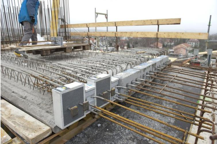
*Für die energetische Sanierung war u.a. der Einbau des Wärmedämmelements Isokorb Typ QPXT für gestützte Konstruktionen nötig. Foto: Schöck Bauteile GmbH, Abdruck honorarfrei.*
