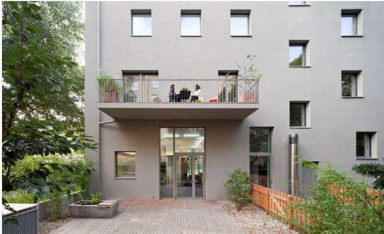
*Gartenseite: Frei auskragende Balkone thermisch entkoppelt mit Passivhaus-zertifizierten Isokorb-Typen von Schöck.*
