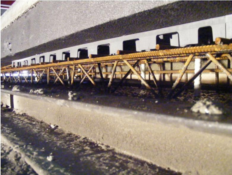
*Wenn Betonaußen- und –innenschale „heiraten“, erfolgt die zug- und druckfeste Verbindung der Wandelemente über die Glasfaserstäbe. Eine Tragschalenbewehrung aus Stahlgitterträgern sorgt im vorliegenden Fall für die erhöhte Stabilität der frei tragenden Sandwichwände. (Foto: Schöck Bauteile GmbH, Abdruck honorarfrei, Belegexemplar erbeten)*
