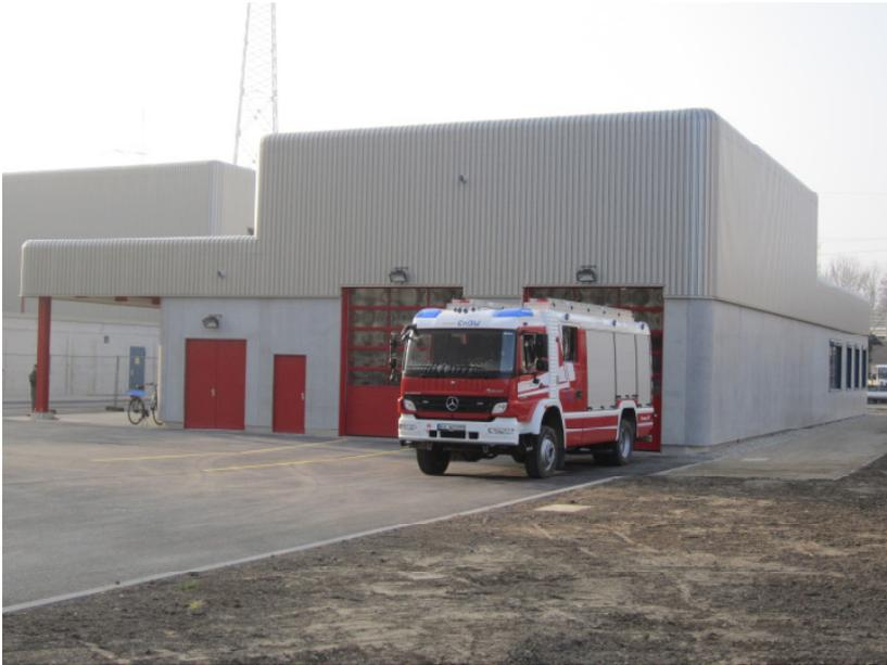
*Die Fassade des neuen Feuerwehrgerätehauses auf dem Gelände des Rheinhafen-Dampfkraftwerks in Karlsruhe besteht aus hoch dämmenden, glasfaserbewehrten Stahlbetonsandwichwänden. (Foto: RBS wave GmbH)*
