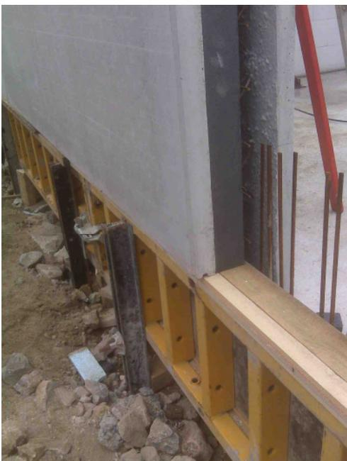
*Nachdem die Eck- bzw. Stoßbewehrung eingebracht wurde, werden die Wandstücke aufgestellt, ausgerichtet und vergossen. Bis zur vollständigen Aushärtung des Ortbetons müssen die Elemente abgestützt werden. (Foto: Schöck Bauteile GmbH, Abdruck honorarfrei, Belegexemplar erbeten)*
