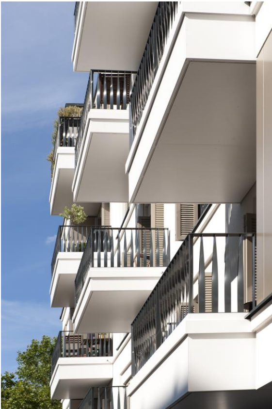
Die mit dem Isokorb RKS angebrachten Balkone dienen gleichzeitig als Dach. Foto: Schöck Bauteile GmbH, Abdruck honorarfrei.
