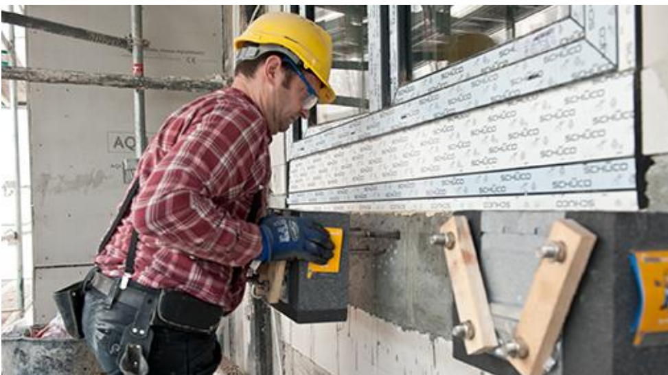
Zur Straßenseite hin konnten die Balkone nicht mit vertikalen Stützen angebracht werden. Die Lösung war der Isokorb RKS für den nachträglichen Balkonanbau. Foto: Schöck Bauteile GmbH, Abdruck honorarfrei.
