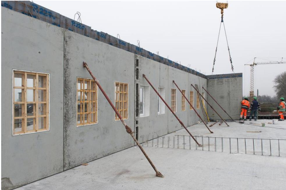
*Die Fenster wurden bereits im Fertigteilwerk in die Wandelemente integriert. Foto: Schöck Bauteile GmbH, Abdruck honorarfrei.*
