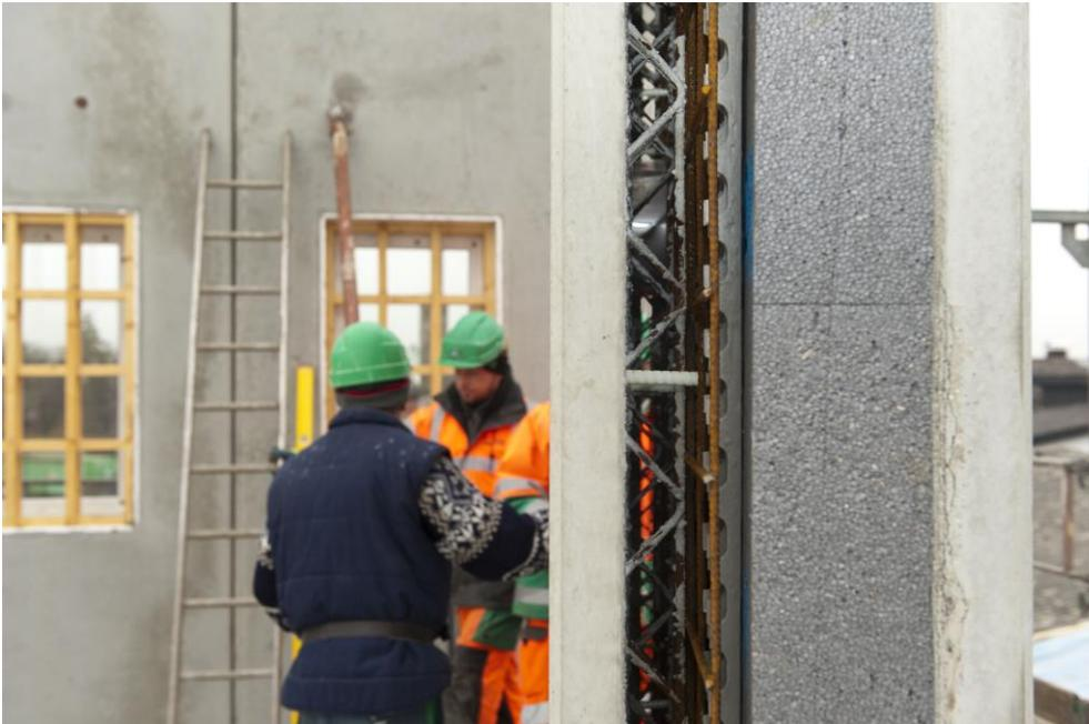
*Die Fassade wurde als kerngedämmte Elementwand realisiert. Der Schöck Thermoanker sorgt für eine wärmebrückenfreie Verbindung zwischen Vorsatz- und Tragschale. Foto: Schöck Bauteile GmbH, Abdruck honorarfrei.*
