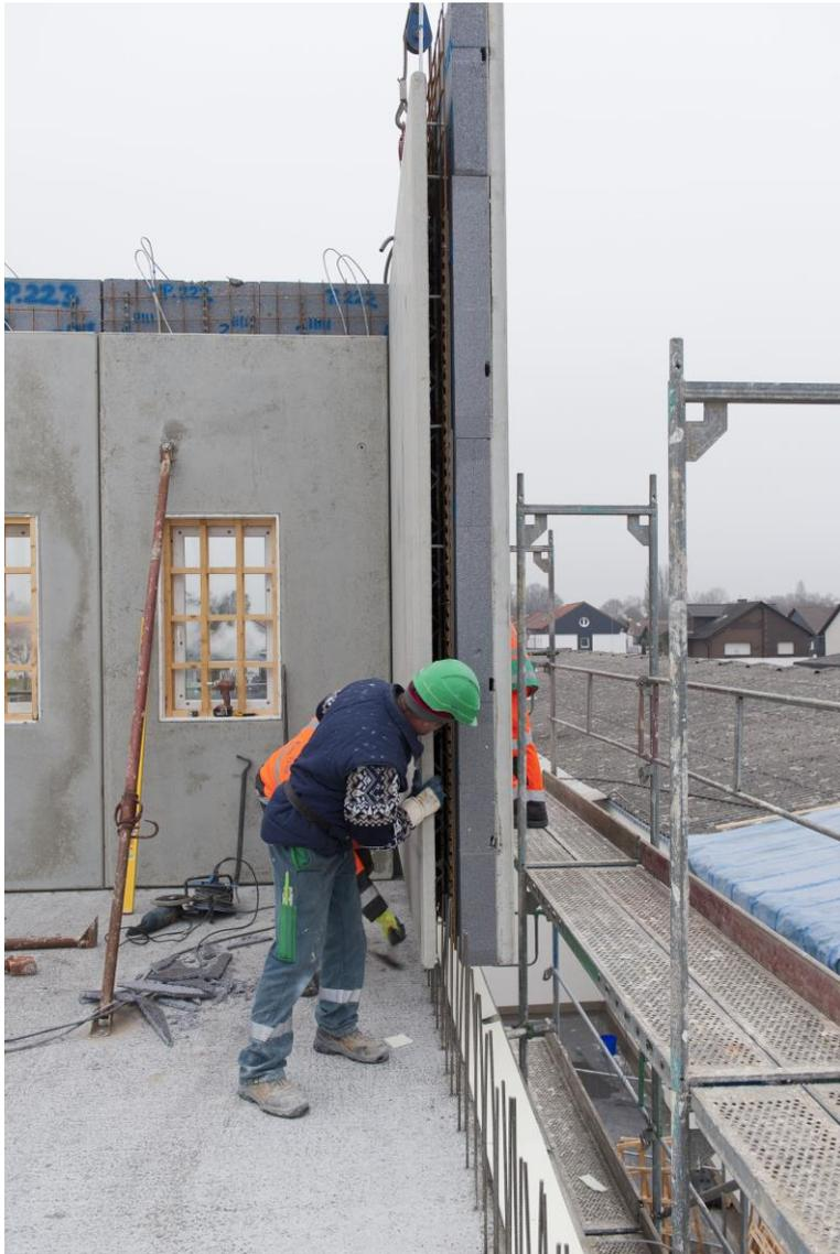
*Auf der Baustelle werden die kerngedämmten Elementwände versetzt. Foto: Schöck Bauteile GmbH, Abdruck honorarfrei.*
