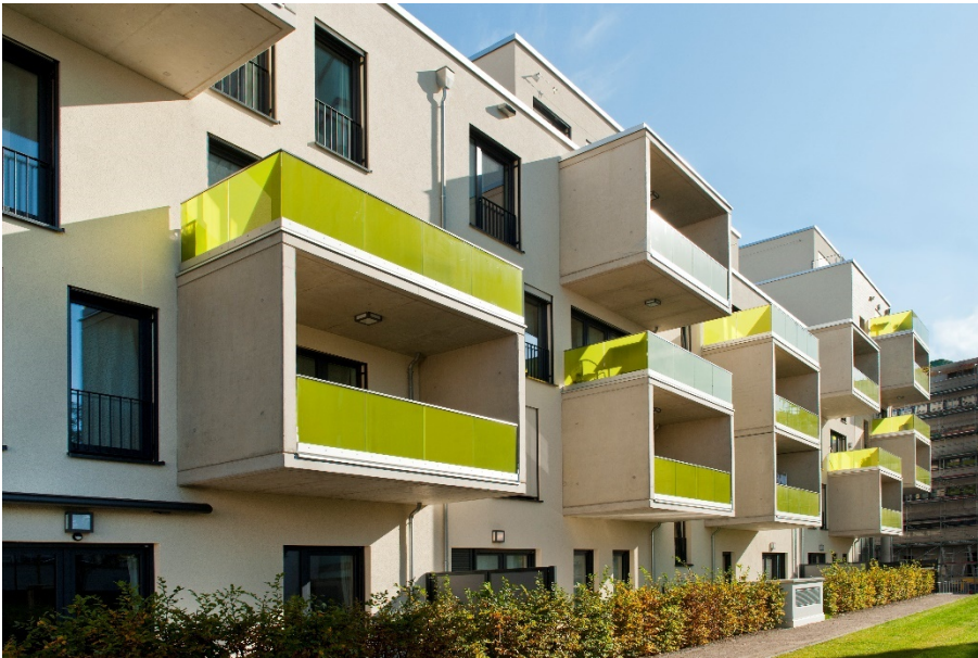
Ein besonderes Merkmal der Fassade sind die vor Ort aus Beton hergestellten Balkone mit grün eingefärbter Glasbrüstung, die wie Rahmen auf die Fassade gesetzt sind. Foto: Schöck Bauteile GmbH, Abdruck honorarfrei.
