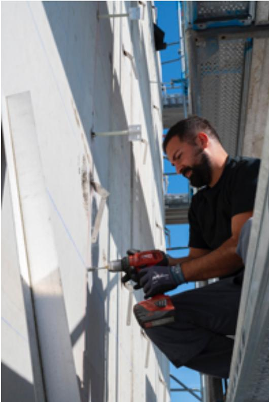
*Nach dem Setzen der Bohrlöcher müssen diese gesäubert werden, bevor Schöck Isolink eingeklebt wird.*
