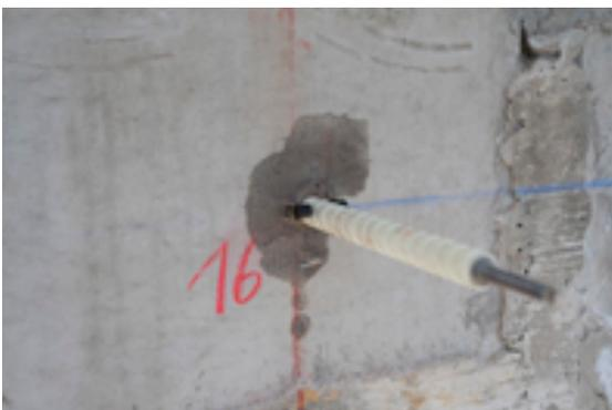
*Mit einer Verankerungstiefe von gerade einmal 40 mm im Beton werden die Bewehrungstreffer auf Betonstahl beim Bohren mit Schöck Isolink Typ F signifikant reduziert.*
