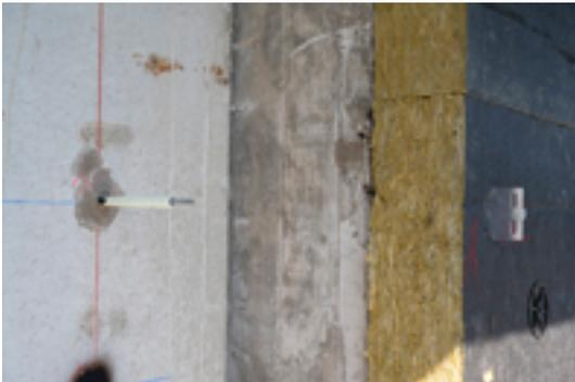
*Die Wärmedämmung liegt vollflächig und ohne Hohlräume an der Wand an.
