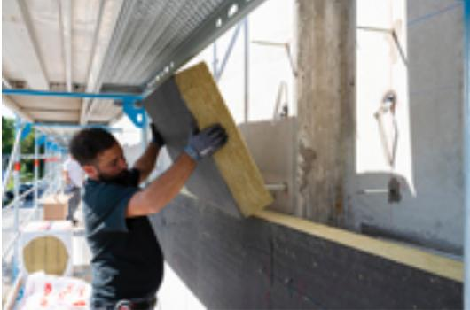
*Ohne Spezialwerkzeug wird die Wärmedämmung über den Fassadenanker Schöck Isolink Typ F gedrückt.
