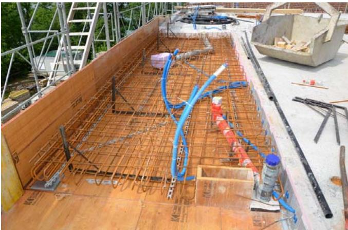
Rund 200 m Vordächer und aussen abgestützte Balkone sind mit dem Schöck Isokorb befestigt.
