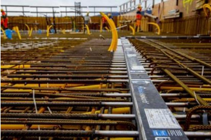
*Rund 1.000 Isokorb K Typen in verschiedenen Sonderanfertigungen werden im Baufeld G an der Europaallee in Zürich verbaut – ein technisch sehr anspruchsvoller Auftrag für die Schöck Bauteile AG.*
