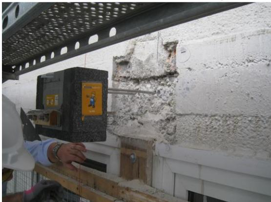
*Der Isokorb R ist das Bindeglied zwischen den Stahlträgern der Passarelle und der bestehenden Betonwand. Er minimiert den Wärmeabfluss und beugt Bauschäden und Schimmelpilzbildung vor.*
