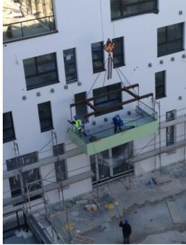
*Die Balkone wurden nach Vorgaben der Architekten beim Metallbauer aus Aluminiumblech, Mineralit, Edelstahl und Verbundsicherheitsglas komplett vorgefertigt und mit einer speziellen Hebekonstruktion per Kran positioniert.*
