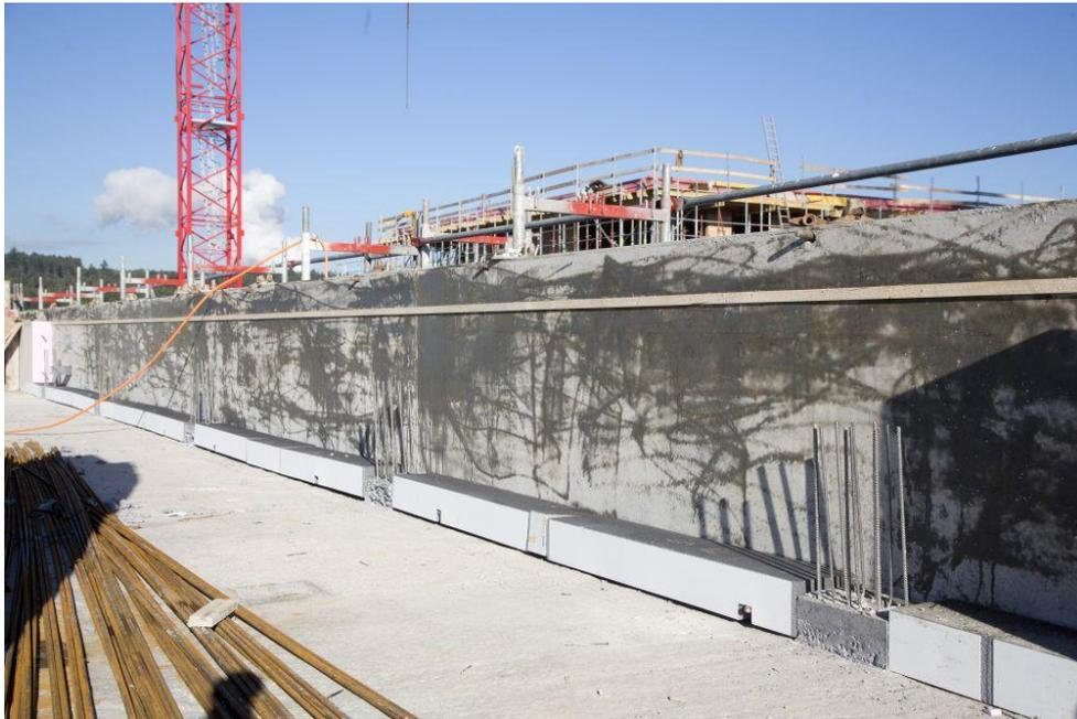
*Die Bewehrung und Dämmung der Balkonbrüstungen in den Attikageschossen besteht aus dem Isokorb Typ ABXT.*
