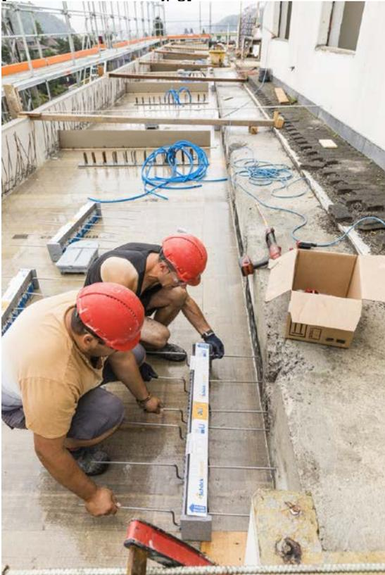
Die beiden Eckbalkone sind nur einseitig abgestützt. Hier übernehmen drei nebeneinander liegende Kragplattenanschlüsse des Typs Isokorb RQP die Trag- und Wärmedämmfunktionen.
