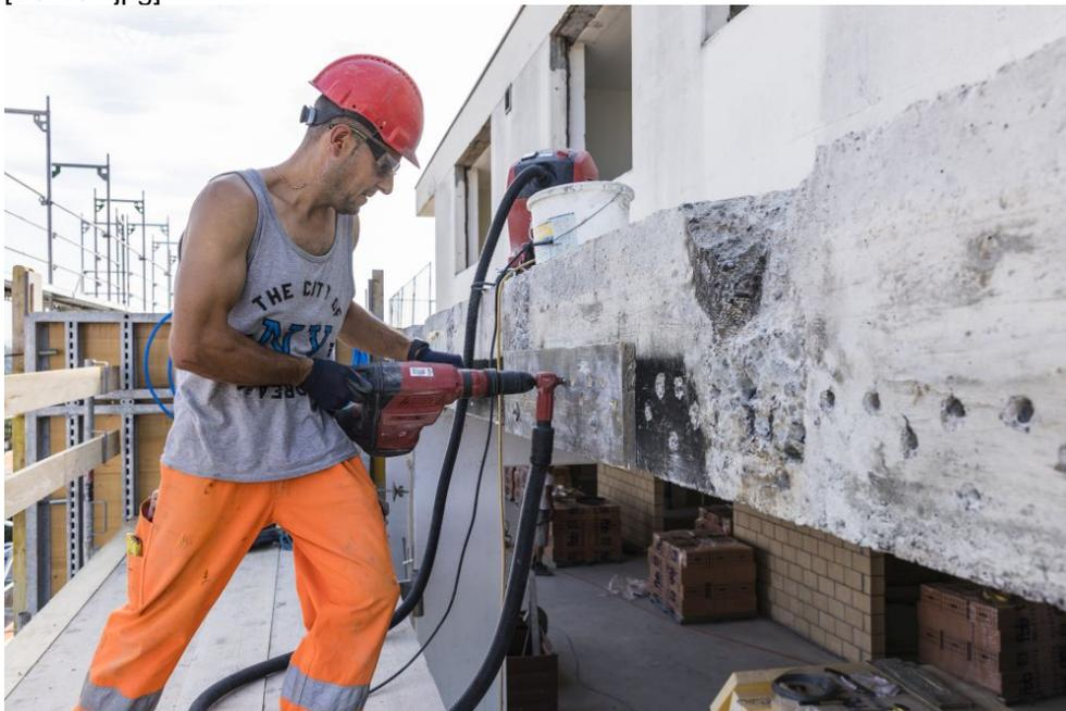
*Tagelange Bohrarbeiten für Hunderte von Löchern auf fünf Stockwerken waren für das Einkleben der Kragplattenanschlüsse in die bestehenden Decken notwendig.*
