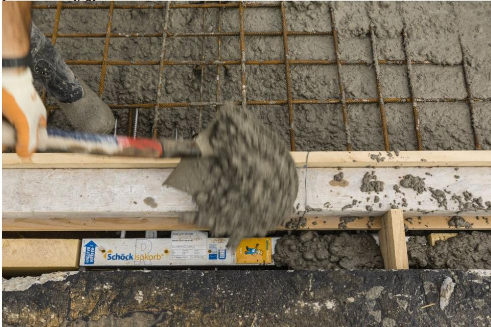
*Die 2.70 m auskragende Balkonplatte wurde in Ortbeton ausgeführt; im Gegensatz zu Fertigelementen konnten so Unregelmässigkeiten des Altbaus besser kompensiert werden.*
