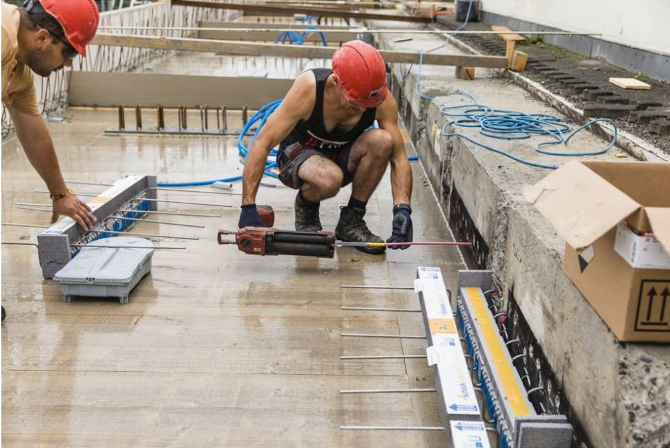
Die bis zu 90 cm tiefen Bohrlöcher wurden mit exakt dosiertem Spezialkleber gefüllt.
