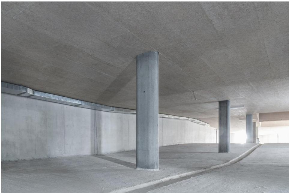
*Dank der thermischen Entkoppelung der Stahlbetonwände konnte die Deckendämmung in der Tiefgarage stark reduziert werden. Dadurch konnte Raumhöhe gewonnen sowie auf eine Flankendämmung auf den Wänden und Stützen gänzlich verzichtet werden.*
