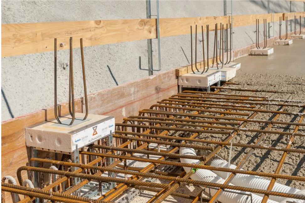
*Für Kurth Architekten eine Premiere: Der Einsatz von Schöck Alphadock für die thermische Entkoppelung der Stahlbetonwände.*
