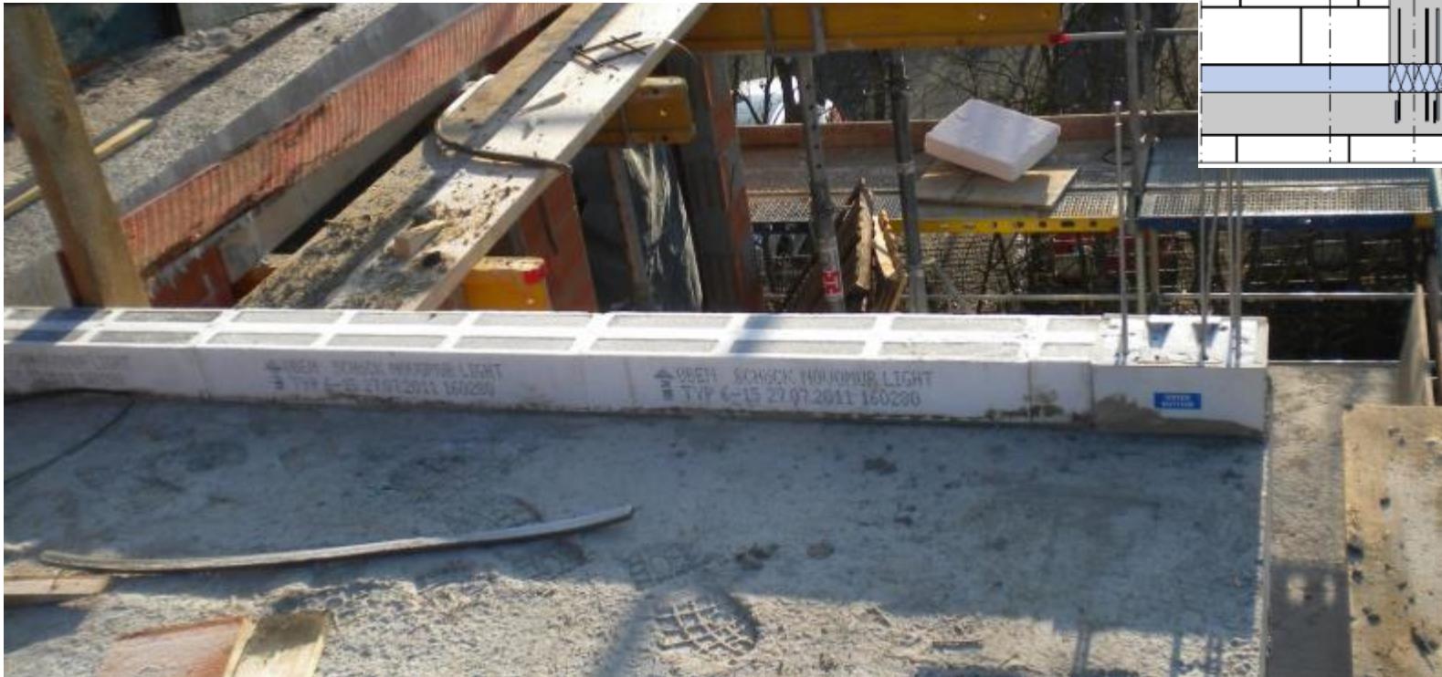
Attika aus Mauerwerk mit Ringanker, thermisch getrennt
