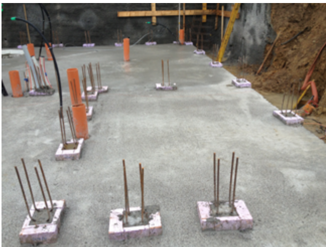
Abb.: Beispiel Spezialelement (isolierender Wandanschluss)
