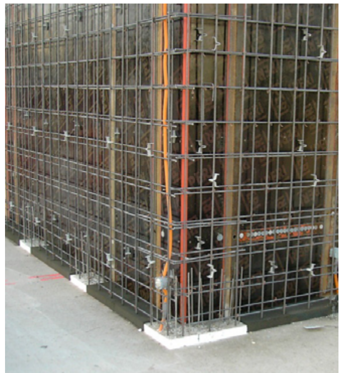
Abb.: Wandarmierung mit wärmedämmten Anschlusselementen auf Betonplatte
