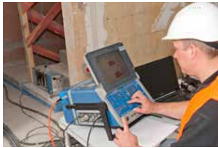
Trittschallmessung der Treppe durch Prüfingenieur.
