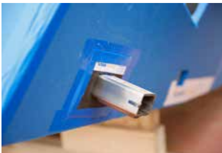
Abb. 9: Typ Q Tragelement mit Brandschutzmanschette einbauen
