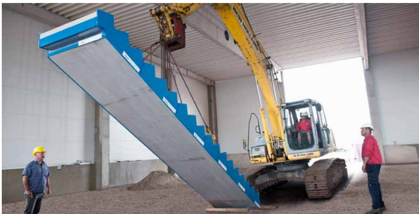
Abb. 11: Die mit Tronsole® umlaufend beklebte Treppe kann direkt auf der Baustelle eingesetzt werden.
