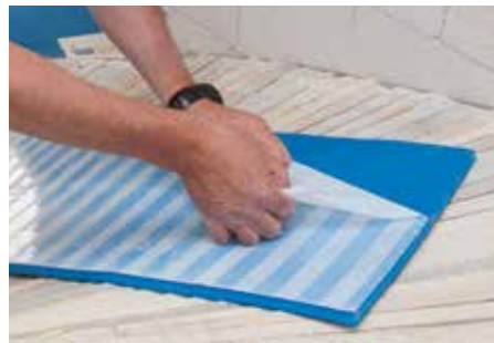
Abb. 4: Typ L Folie zur Hälfte entfernen
