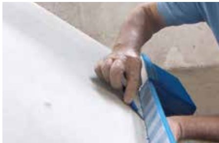
Abb. 6: Typ L Klebefolie einritzen
