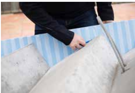
Abb. 6: Typ L Klebefolie einritzen
