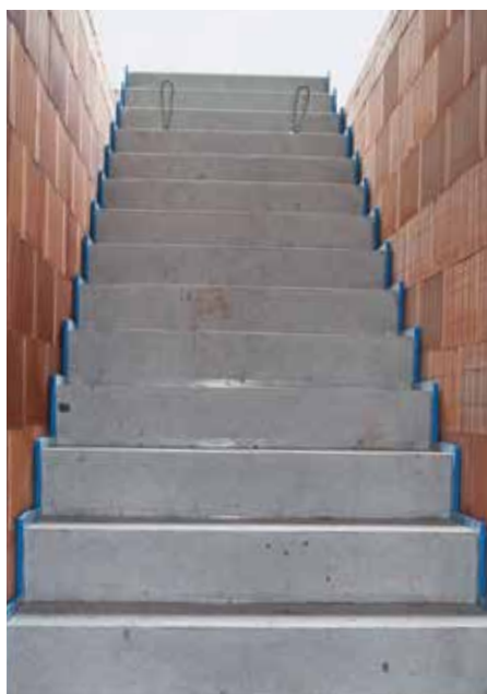
Abb. 13: Im eingebauten Zustand ist die umlaufende Schöck Tronsole® als blaue Linie deutlich erkennbar.
