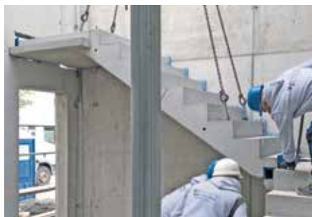
Abb. 10: Treppe einfahren und absetzen
