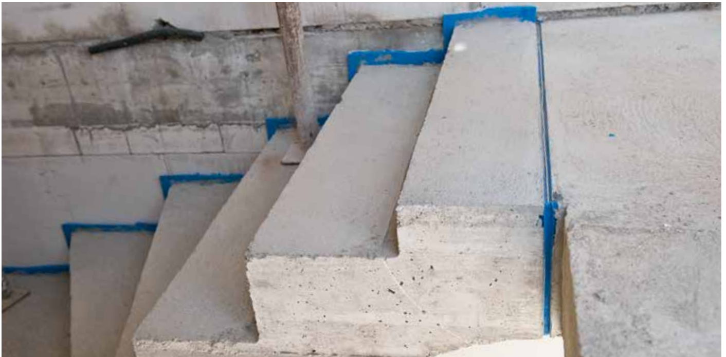
Abb. 12: Gerade Fugenausbildung am Treppenaustritt
