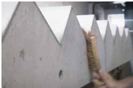
Abb. 3: Staub und Schmutz entfernen
