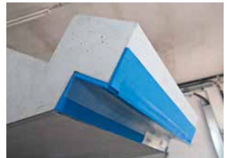
Abb. 5: Typ BZ fertig aufgeklebt
