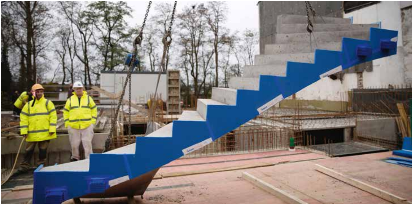
Abb. 11: Treppe anheben und einfahren
