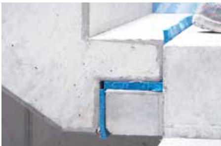
Abb. 13: Konsolaufleger mit Typ BZ
