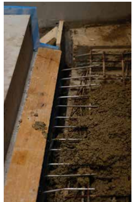
Abb. 13: Anschlussbereich Typ T betonieren
