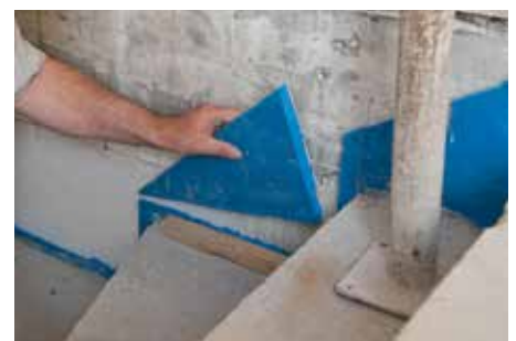
Abb. 11: Typ L mit Überstand zuschneiden
