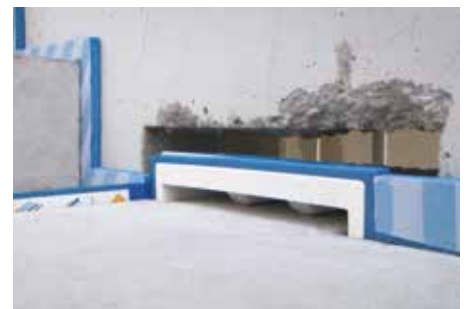
Abb. 11: Wandöffnungen mit Mörtel verfüllen
