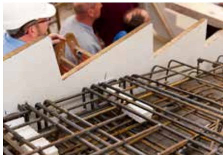
Abb. 4: Armierung verlegen und betonieren
