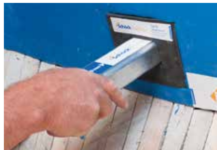
Abb. 7: R 90 Brandschutzmanschette einbauen; Typ Q Tragelement einschieben
