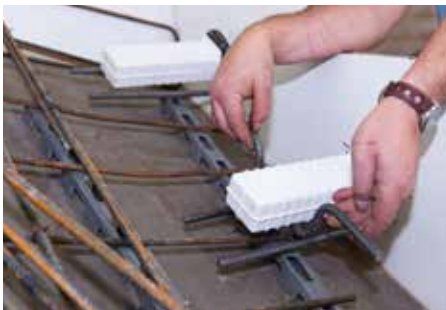
Abb. 3: Hutbügel einsetzen
