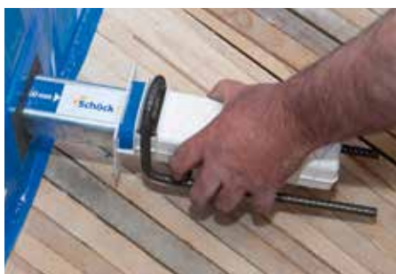
Abb. 9: Typ Q Laufhülse aufstecken
