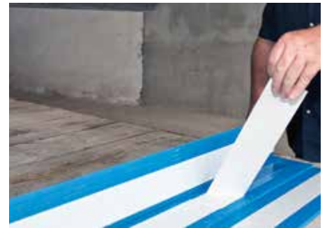
Abb. 2: Typ BZ Schutzfolie abziehen
