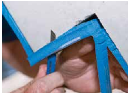
Abb. 4: Typ BZ Überstand abschneiden
