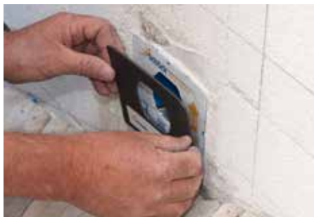
Abb. 6: Typ Q Wandelement einmauern; R 90 Brandschutzabdeckung aufbringen
