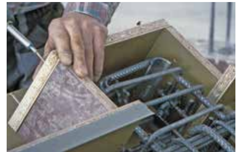
Abb. 2: Konsole fertig schalen, anschliessend betonieren
