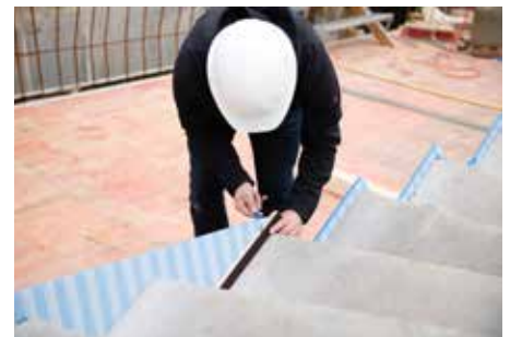
Abb. 8: Typ L mit Überstand zuschneiden
