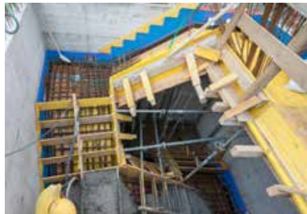
Entstehung der blauen Linie im Ortbeton
