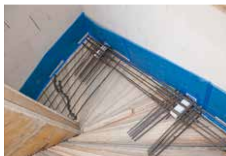
Abb. 10: Bewehrung verlegen und betonieren
