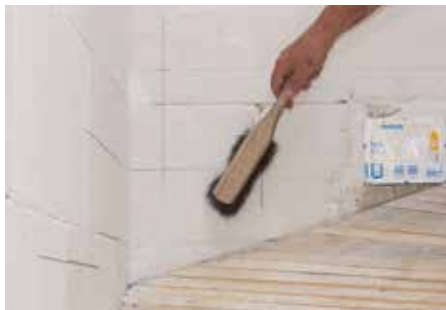
Abb. 3: Staub und Schmutz entfernen
