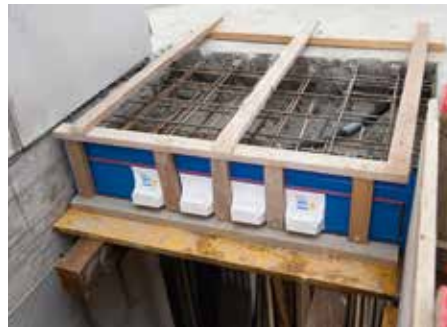
Abb. 1: Typ T einsetzen und stützen
