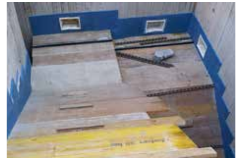
Schallgedämmter Anschluss an die Treppenhauswand
