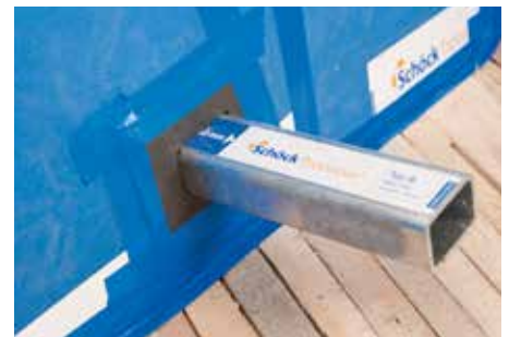
Abb. 8: Fugen mit Klebeband abdecken
