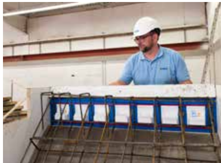
Abb. 1: Typ T einsetzen und stützen
