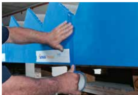
Abb. 10: Typ L Fugen mit Klebeband abdecken
