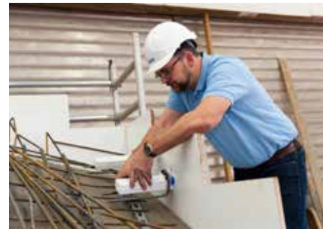
Abb. 2: Typ Q Laufhülse einbauen
