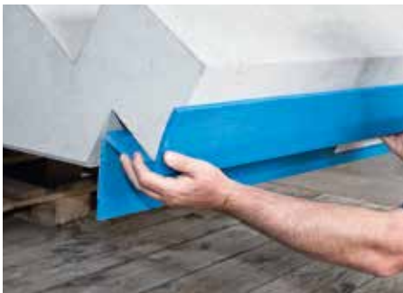
Abb. 3: Typ BZ ausrichten und aufkleben
