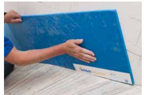
Abb. 5: Typ L untere Hälfte aufkleben
