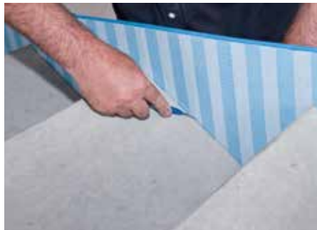
Abb. 7: Typ L Folie einritzen
