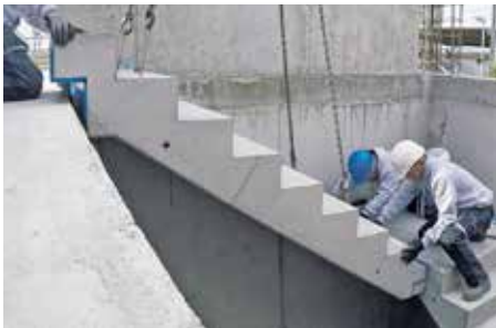
Abb. 12: Treppenlauf wird eingesetzt.
