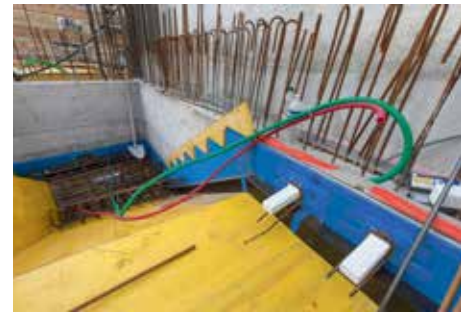
Einbau Tronsole® Typ Q über den Lichtbändern
