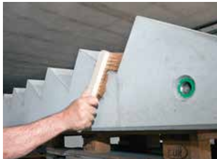
Abb. 1: Staub und Schmutz entfernen
