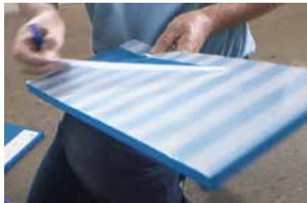
Abb. 7: Typ L Klebefolie entfernen und aufkleben
