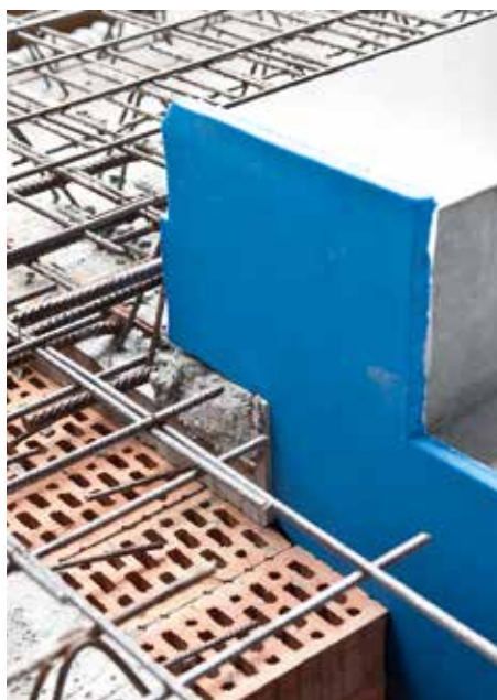
Abb. 12: Typ BZ oberes Auflager Elementdecke
