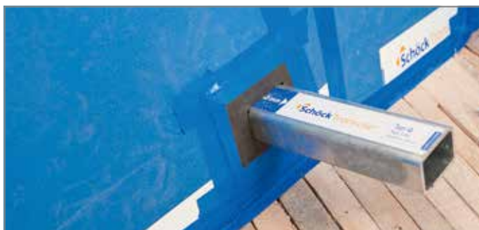
Abb. 69: Tragelement montieren und Brandschutzmanschette abkleben
