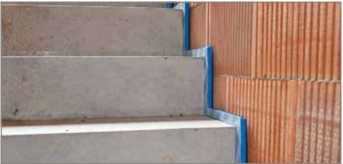
Abb. 147: Überstand der Fugenplatte kontrollieren
