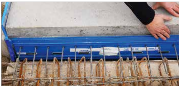
Abb. 98: Treppe einsetzen und stützen
