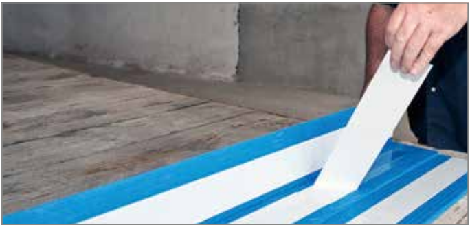
Abb. 106: Schutzfolie von Tronsole® Typ BZ abziehen
