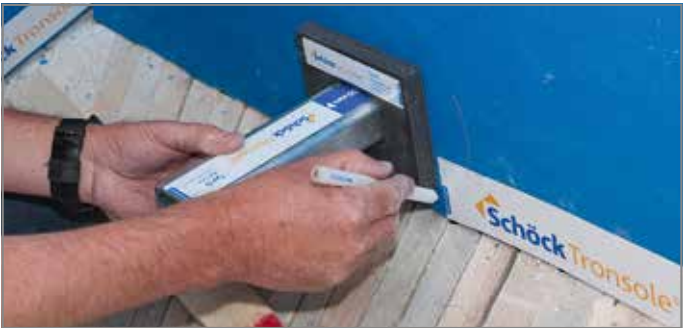
Abb. 65: Brandschutzmanschette auf Fugenplatte Typ L anzeichnen
