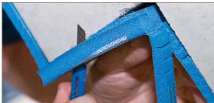
Abb. 108: Tronsole® Typ BZ bündig mit der Treppe zuschneiden
