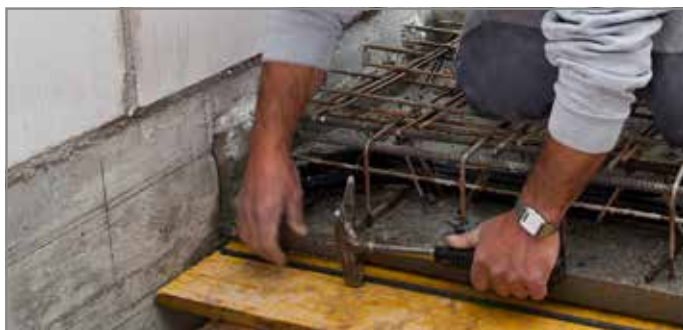
Abb. 89: Untere Nagelleiste anbringen, Abstand von \geq 40 mm zur Tronsole® Typ T einhalten
