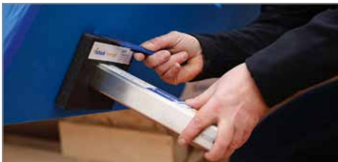
Abb. 76: Geometrie der Brandschutzmanschette ausschneiden
