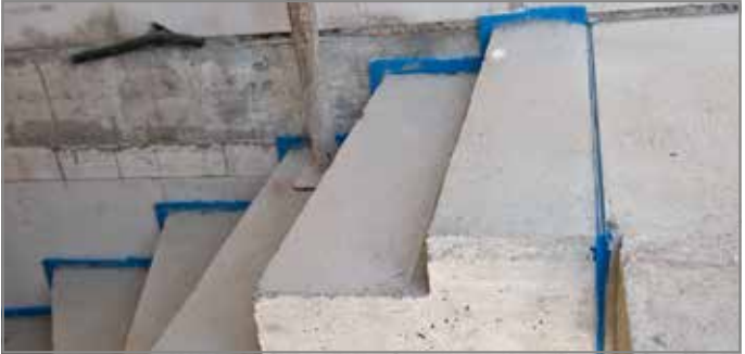
Abb. 136: Gerade Fugenausbildung am Treppenaustritt
