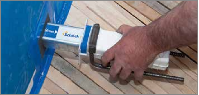
Abb. 71: Laufhülse aufstecken und gegen Betonschlämme abkleben
