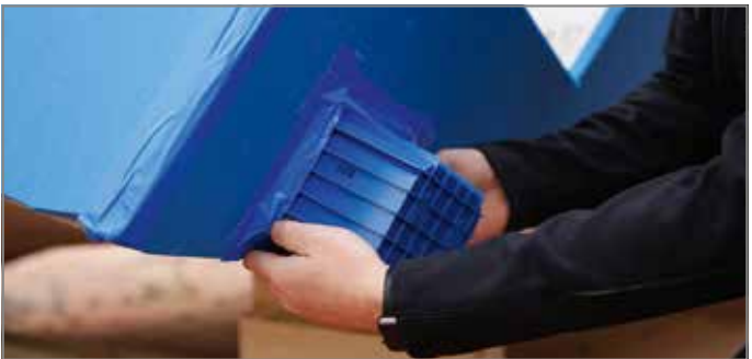
Abb. 82: Wandelement für Einbauzustand waagrecht ausrichten und abkleben
