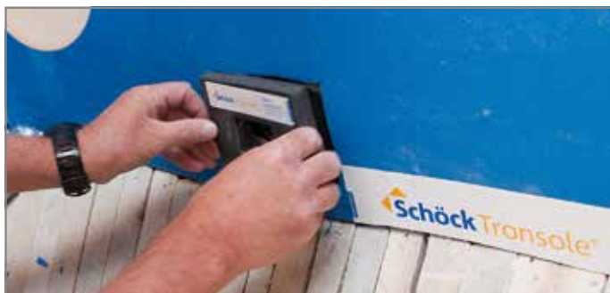
Abb. 68: Brandschutzmanschette einsetzen
