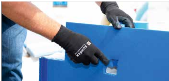
Abb. 36: Geometrie der Podesthülse ausschneiden
