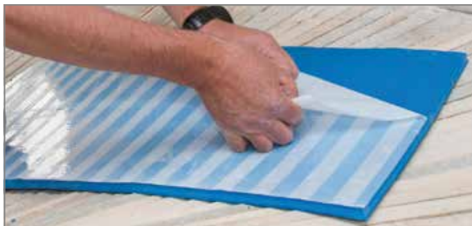
Abb. 130: Schutzfolie von Tronsole® Typ L zur Hälfte oder circa 150 mm entfernen
