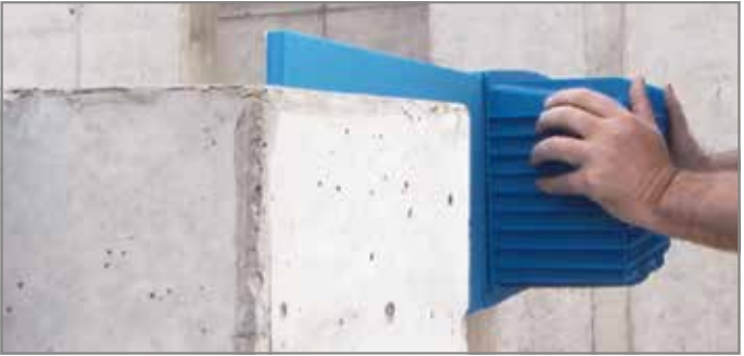
Abb. 53: Tronsole® Typ Z aufstecken
