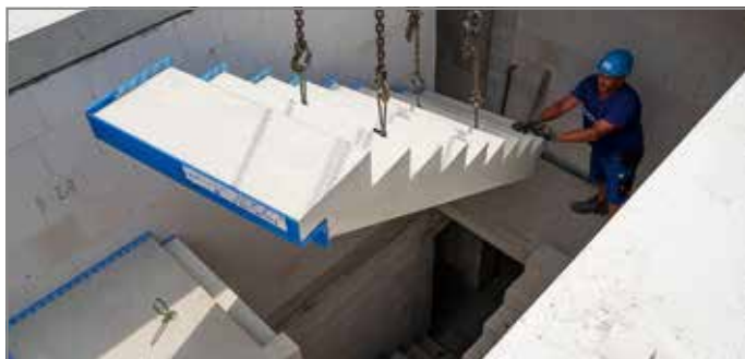
Abb. 49: Treppenlauf einheben
