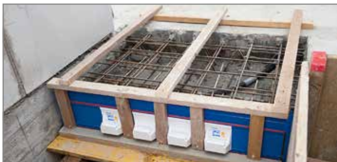
Abb. 95: Vor dem Betonieren
