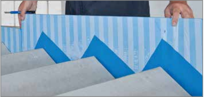
Abb. 140: Tronsole® Typ L ankleben
