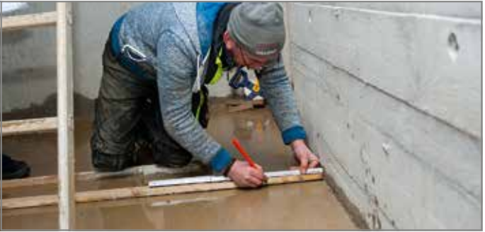
Abb. 115: Position der Tronsole® Typ D auf der Bodenplatte einzeichnen
