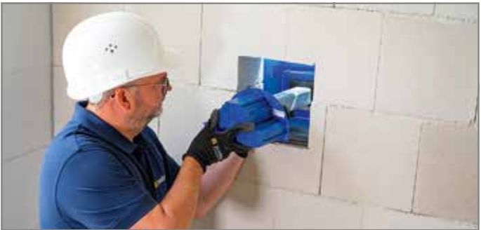
Abb. 45: Tragelement und Wandelement in Podesthülle einfahren
