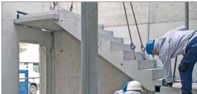
Abb. 56: Treppenlauf positionieren
