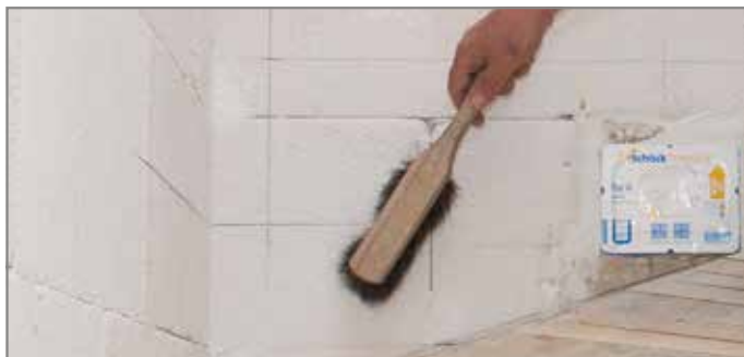
Abb. 125: Staub und lose Teile entfernen
