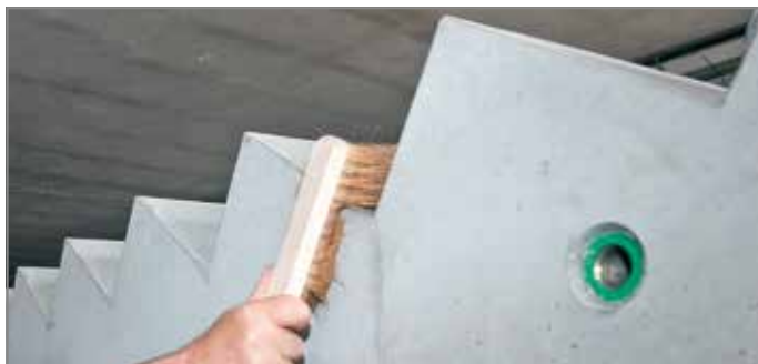
Abb. 137: Staub und lose Teile entfernen
