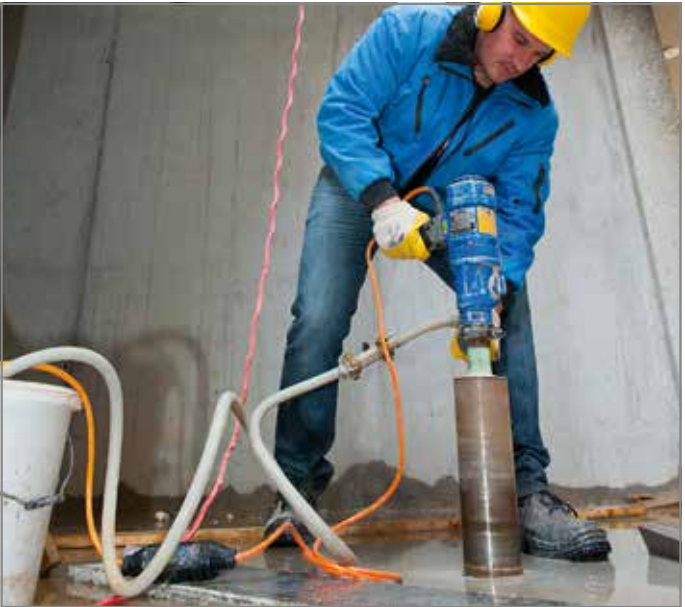
Abb. 116: Kernbohrung mit 100 mm Durchmesser in Bodenplatte setzen
