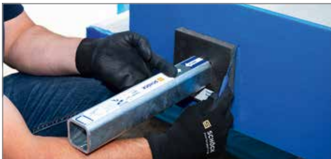
Abb. 37: Brandschutzmanschette und Trageelement positionieren, Geometrie der Brandschutzmanschette auf Fugenplatte Typ L einritzen
