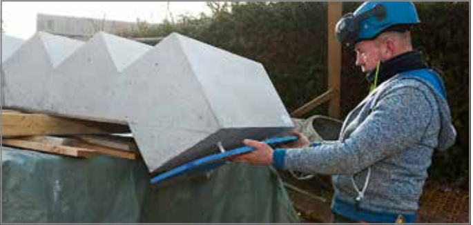
Abb. 119: Am Treppenlauf Staub und lose Teile entfernen und Tronsole® Typ B montieren
