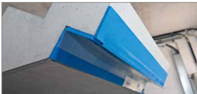
Abb. 109: Tronsole® Typ BZ fertig montiert
