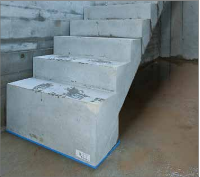
Abb. 124: Der Treppenlauf ist auf Tronsole® Typ B und Typ D schalldämmend gelagert. Die Fuge zwischen Treppenlauf und Treppenhauswand ist hier als breite Luftfuge ausgebildet.
