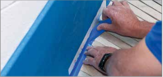
Abb. 70: Zur Vermeidung von Schallbrücken ist die Tronsole® Typ Q und Typ L gegen Betonschlämme abzukleben
