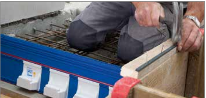
Abb. 92: Obere Nagelleiste anbringen
