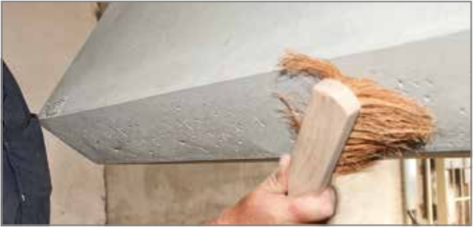
Abb. 104: Staub und lose Teile entfernen
