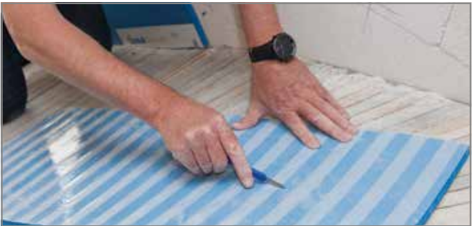
Abb. 129: Schutzfolie etwa 150 mm von der Unterkante entfernt einritzen und abziehen
