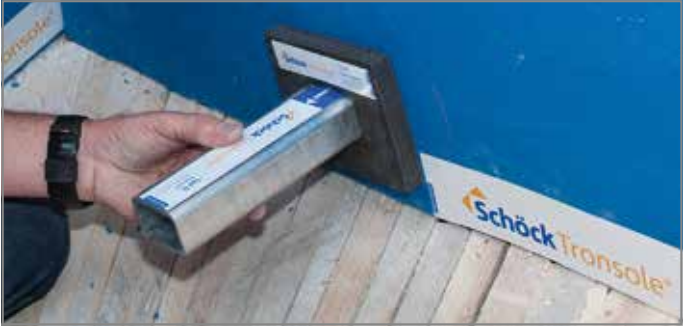
Abb. 64: Tronsole® Typ L ankleben (siehe Seite 70), Brandschutzmanschette und Tragelement positionieren
