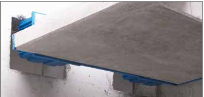
Abb. 55: Treppe mit Tronsole® Typ Z in die Auflagertaschen einführen
