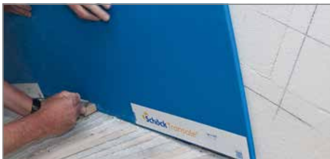
Abb. 126: Unteres Laufprofil von Tronsole® Typ L anzeichnen
