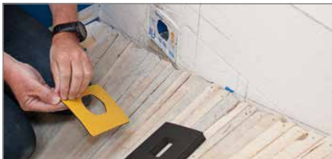
Abb. 62: Bei Brandschutzanforderung R 90 die Schutzfolie der Brandschutzabdeckung abziehen
