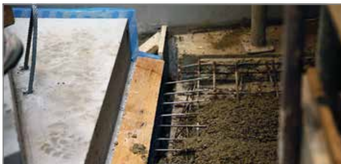
Abb. 99: Anschlussbereich betonieren
