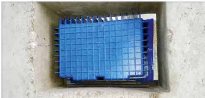
Abb. 57: Höheneinstellung Tronsole® Typ Z vollflächig und kraftschlüssig mit druckfesten Unterlegplatten vornehmen
