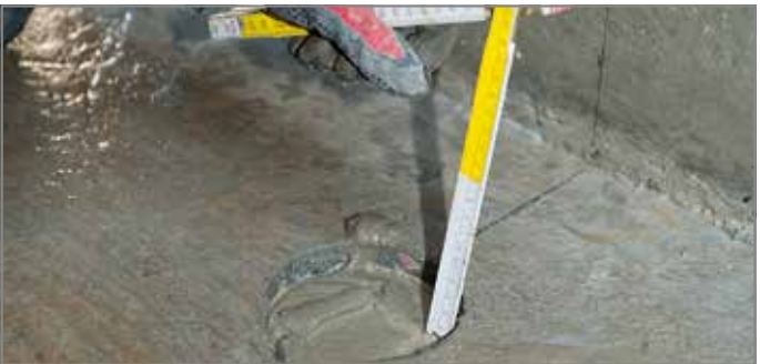
Abb. 121: Kernbohrung mit fließfähigem Beton bis 10 mm unterhalb der Oberkante füllen
