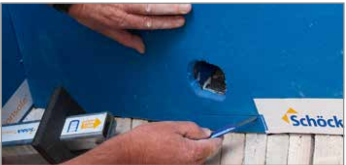
Abb. 66: Geometrie der Brandschutzmanschette ausschneiden
