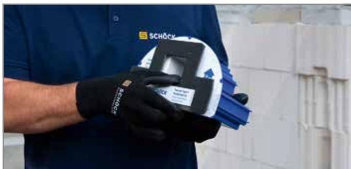
Abb. 43: Brandschutzabdeckung am Wandelement aufkleben
