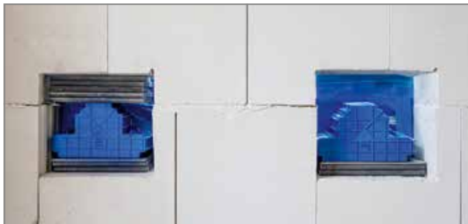
Abb. 47: Wandelement abkleben. Bei abhebenden Kräften sowohl unten als auch oben mit druckfesten Unterlegplatten unterlegen
