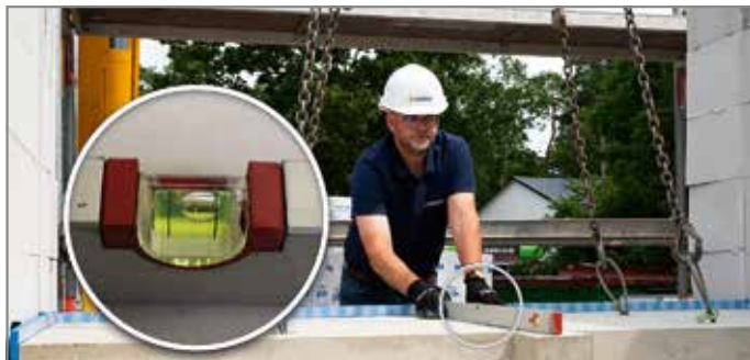
Abb. 48: Einfederung gemäss Technischer Information berücksichtigen
