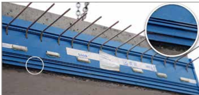
Abb. 103: Nagelleiste unbedingt entfernen
