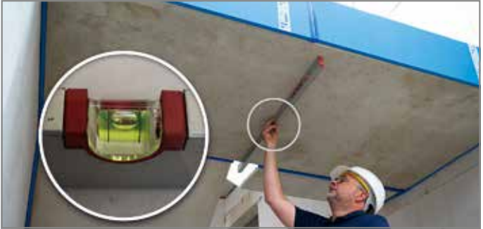
Abb. 50: Podest nach Ablegen der Treppenläufe auf waagerechten Sitz überprüfen
