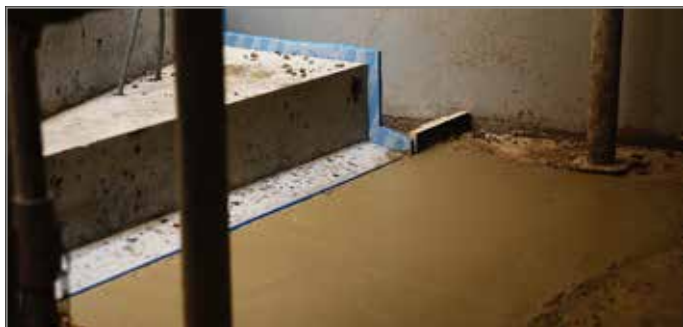
Abb. 100: Anschlussbereich betoniert
