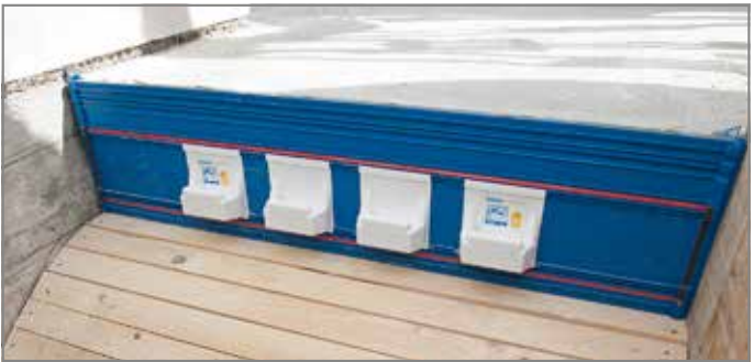
Abb. 97: Oberer Anschluss mit Tronsole® Typ T
