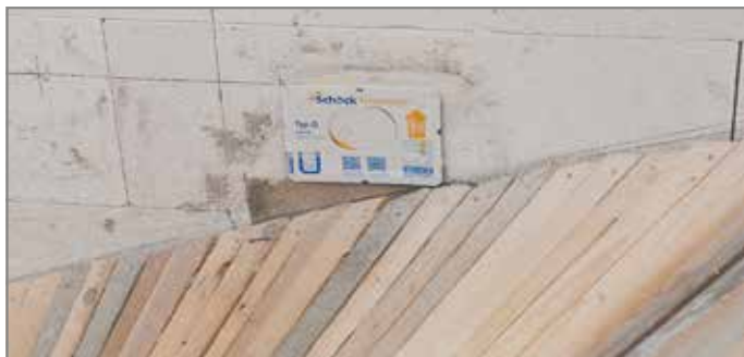
Abb. 61: Wandelement Tronsole® Typ Q in KS-Wand eingemauert
