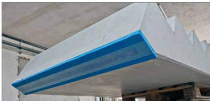
Abb. 114: Tronsole® Typ B aufgeklebt
