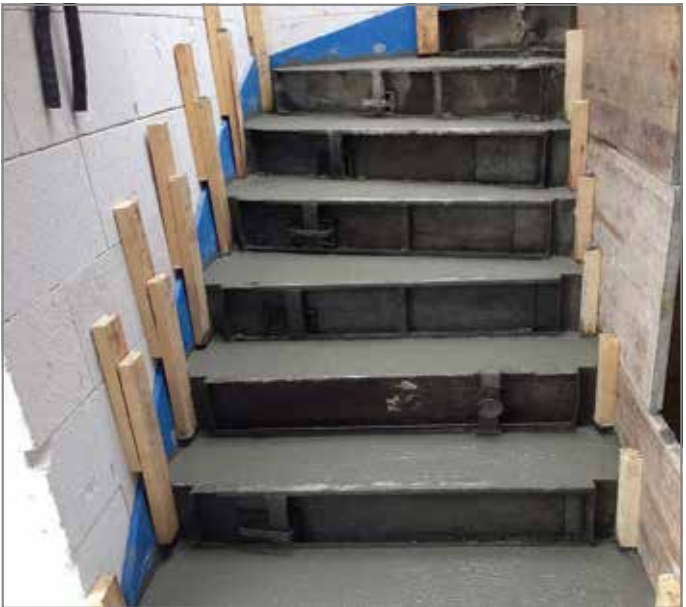
Abb. 133: Treppenlauf betonieren
