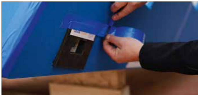
Abb. 78: Brandschutzmanschette einsetzen und abkleben
