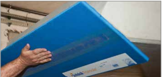
Abb. 112: Tronsole® Typ B an den Treppenfuss ankleben und andrücken, sodass die Position des Elastomerlagers Elodur® im Treppenfuss mittig liegt
