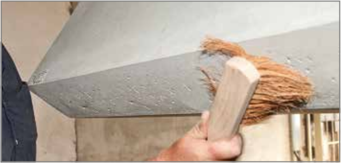
Abb. 110: Staub und lose Teile entfernen
