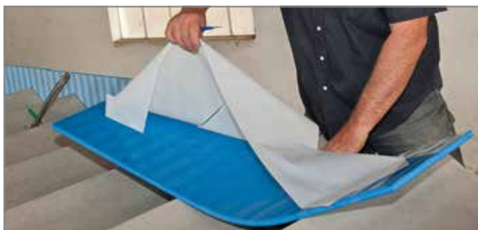
Abb. 139: Im Bereich des Treppenlaufs Schutzfolie von Tronsole® Typ L abziehen
