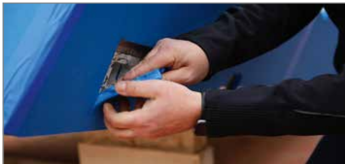
Abb. 77: Ausschnitt für die Brandschutzmanschette entfernen
