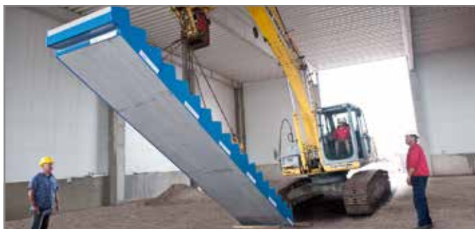
Abb. 145: Vorbereitete Treppe einsetzen
