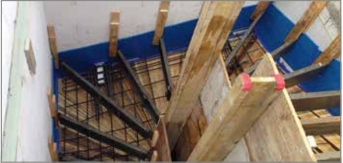
Abb. 132: Treppenlauf bewehren und Stufenbretter anbringen
