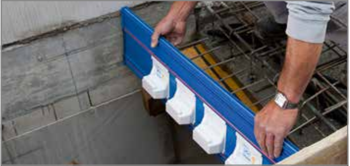
Abb. 90: Tronsole® Typ T einsetzen
