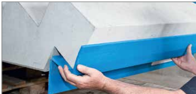
Abb. 107: Obere Schenkel von Tronsole® Typ BZ ankleben
