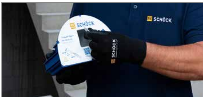
Abb. 42: Klebefolie am Wandelement an der perforierten Stelle entfernen
