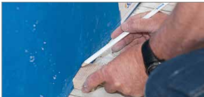
Abb. 127: Unteres Laufprofil von Tronsole® Typ L anzeichnen
