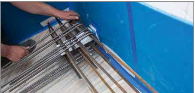
Abb. 72: Erforderliche Zusatzbewehrung verlegen
