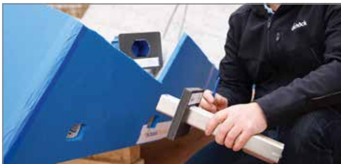
Abb. 75: Tragelement bei Laufhülse positionieren
