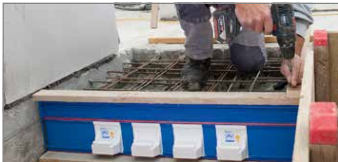
Abb. 94: Tronsole® Typ T abstützen
