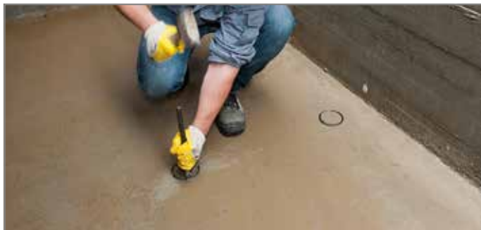
Abb. 117: Kernbohrung ausbrechen
