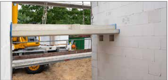
Abb. 40: Podest zwischen den Treppenhauswänden einheben
