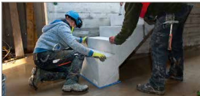
Abb. 123: Treppe absetzen
