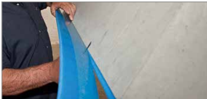
Abb. 113: Überstand von Tronsole® Typ B bündig abschneiden
