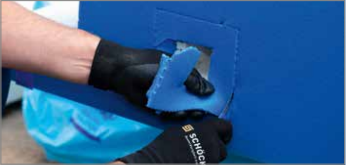
Abb. 38: Geometrie der Podesthülse ausschneiden
