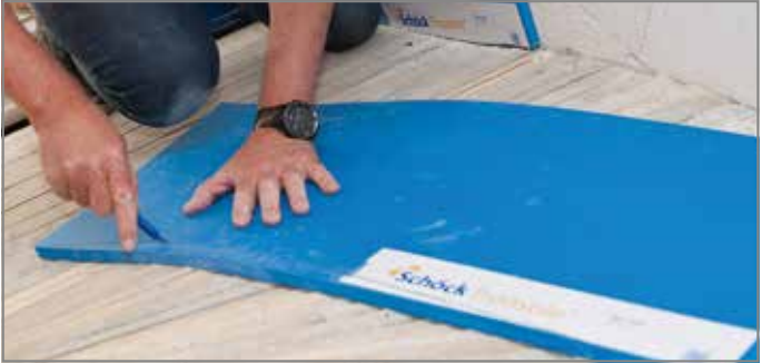
Abb. 128: Unteres Laufprofil von Tronsole® Typ L zuschneiden
