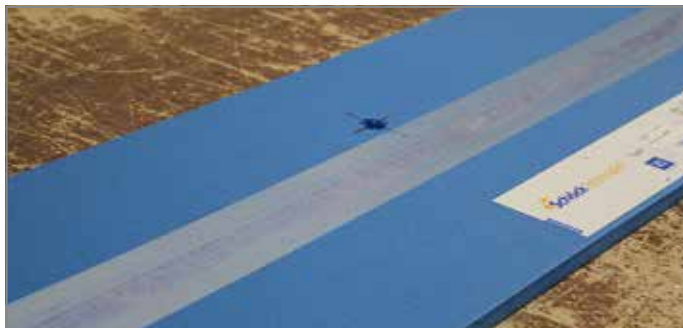
Abb. 118: Position der Tronsole® Typ D einzeichnen und ausschneiden
