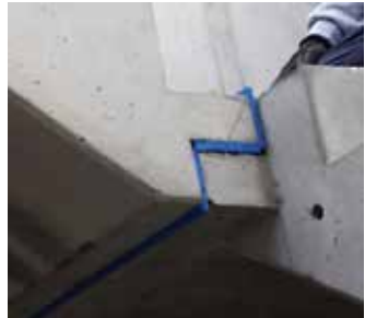
Abb. 2: Korrekte Ausführung – blaue Linie zeigt durchgängige Entkopplung
