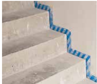
Abb. 4: Korrekte Ausführung – blaue Linie zeigt durchgängige Entkopplung
