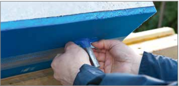
Abb. 120: Tronsole® Typ D und Typ B abkleben, sodass keine Schlämme einlaufen können
