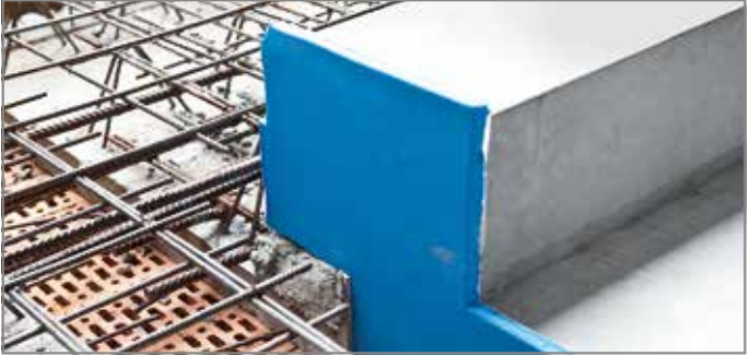
Abb. 146: Oberes Auflager der Treppe kontrollieren
