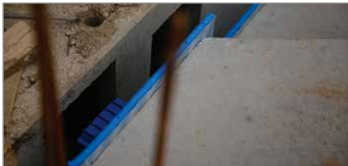
Abb. 83: Treppe mit Tronsole® Typ Q in Auflagertaschen einführen
