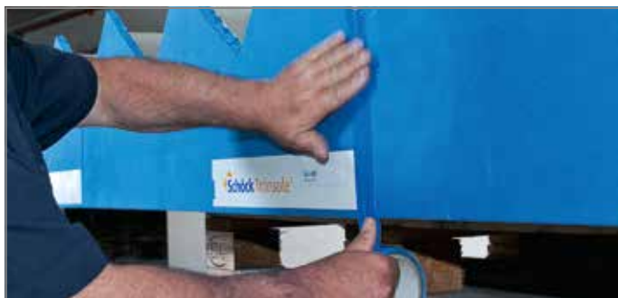
Abb. 144: Stöße von Tronsole® Typ L verkleben
