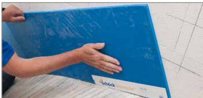
Abb. 131: Tronsole® Typ L aufkleben
