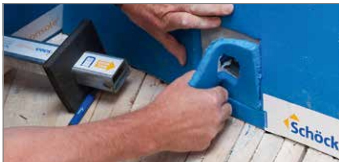
Abb. 67: Ausschnitt für die Brandschutzmanschette entfernen
