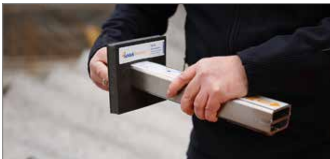
Abb. 74: Bei Brandschutzanforderung R 90 Brandschutzmanschette auf Tragelement aufstecken
