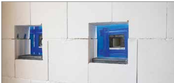
Abb. 41: Podest auf Höhe der Wandaussparungen positionieren
