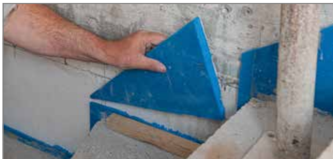
Abb. 134: Tronsole® Typ L mit (ca. 30 mm) Überstand abschneiden
