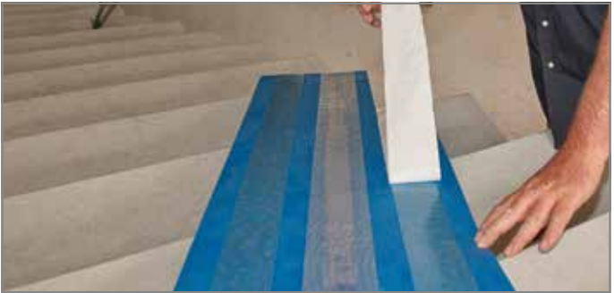
Abb. 111: Schutzfolie von Tronsole® Typ B abziehen
