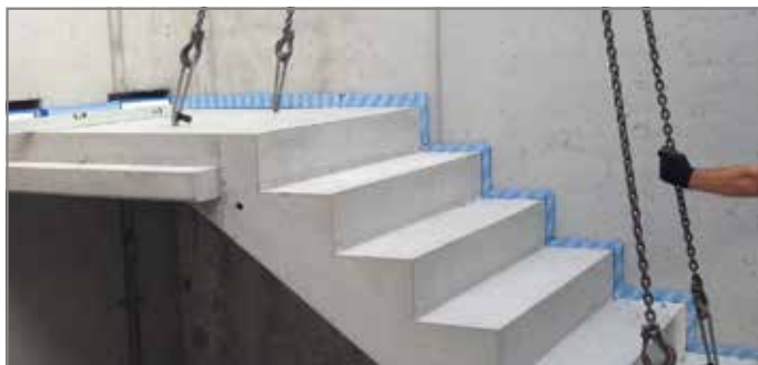
Abb. 58: Treppe mit Tronsole® Typ BZ und Typ Z absetzen
