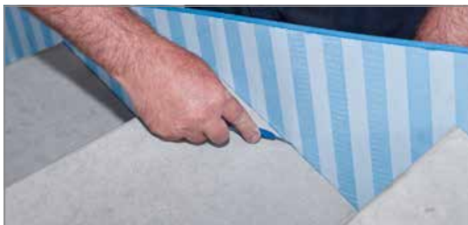
Abb. 138: Schutzfolie im Bereich der zu beklebenden Fläche einschneiden
