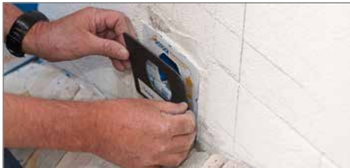
Abb. 63: Brandschutzabdeckung aufkleben
