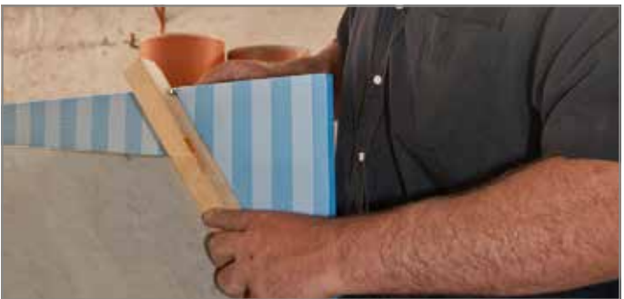
Abb. 142: Schöck Tronsole® L mit Überstand (ca. 30 mm) abschneiden
