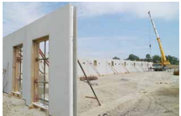
4. Valmis asennettu eristetty seinä
