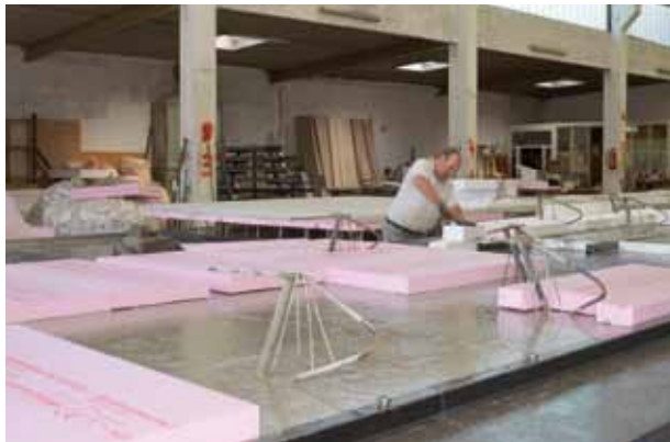
1. Asenna lämmöneriste tuureen betonikuoren päälle
