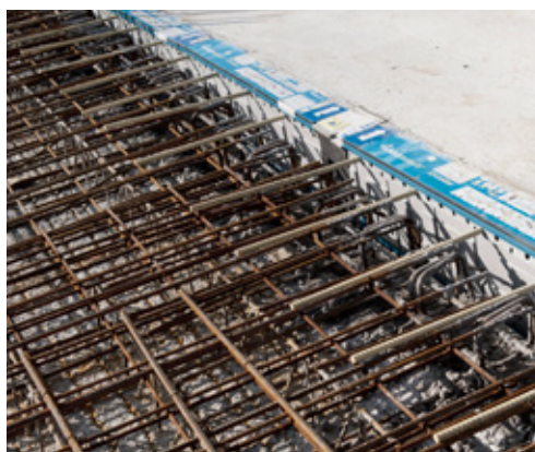
Vgradnja montažnega balkona na gradbišču
