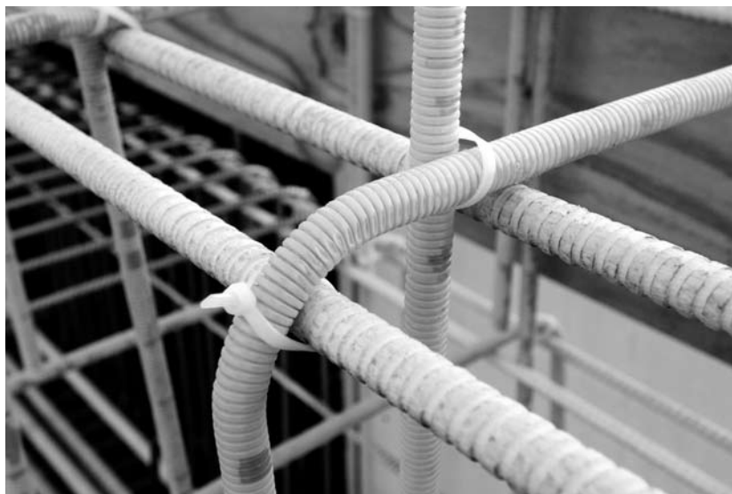
Staven gekoppeld met kunststof tie-rips
